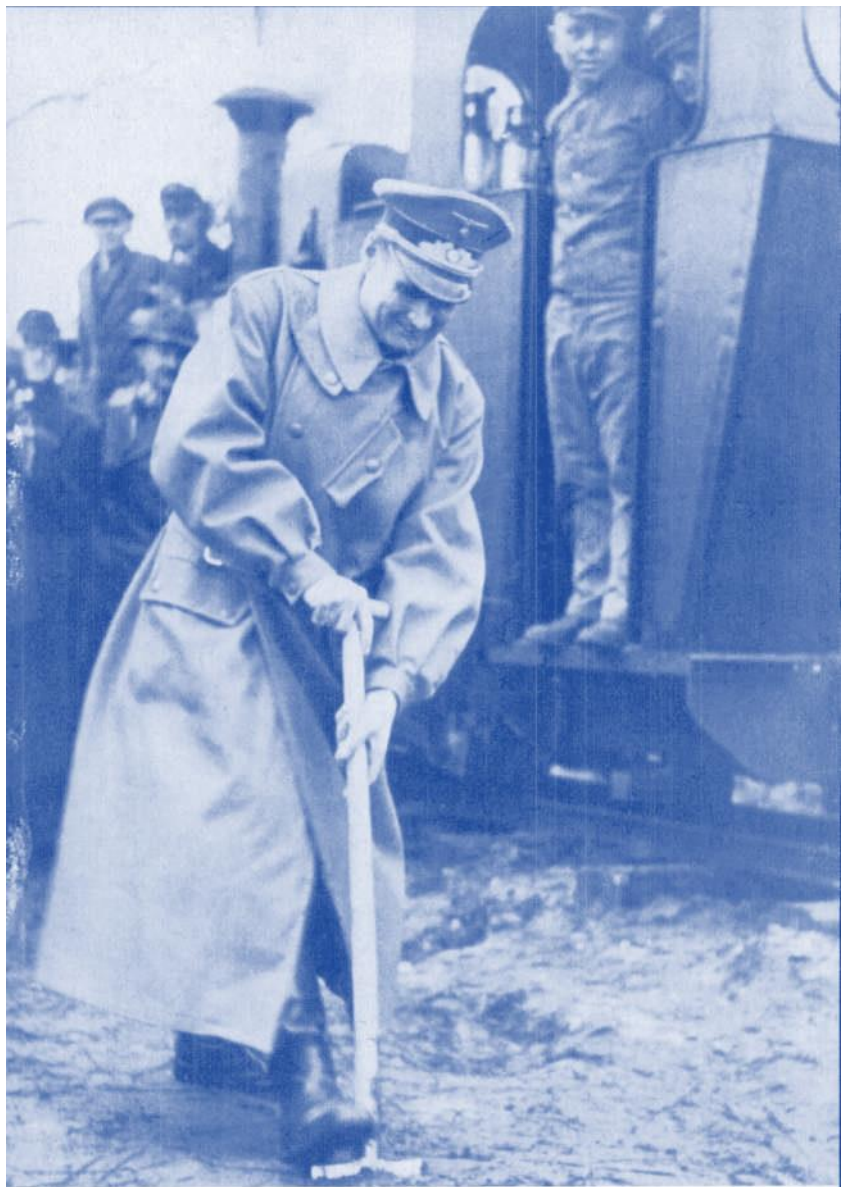
Der erste Spatenstich zum neuen Oder-Donau-Kanal im Dezember 1939.
