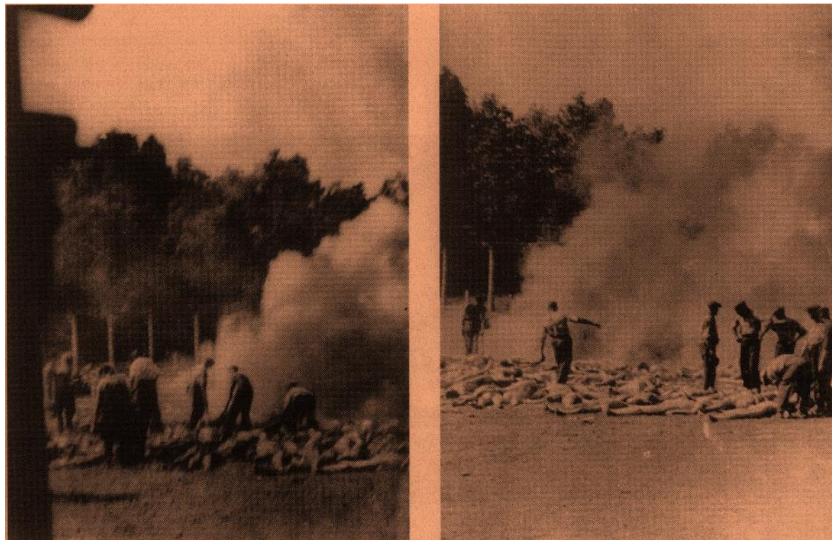
Die Fotos wurden von Häftlingen des Sonderkommandos heimlich aufgenommen. Die Abbildungen 3 und 4 zeigen Sonderkommando -Häftlinge bei der Leichenverbrennung – vermutlich von ungarischen Juden – in den Gruben bei Krematorium IV. Abbildung 5 zeigt Frauen auf dem Weg von der Entkleidungs- zur Gaskammer.
