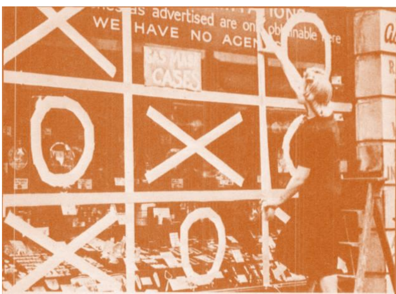
Ladeninhaber bekleben die Fensterscheiben mit Papierstreifen, um die Auswirkungen der Druckwellen zu vermindern
