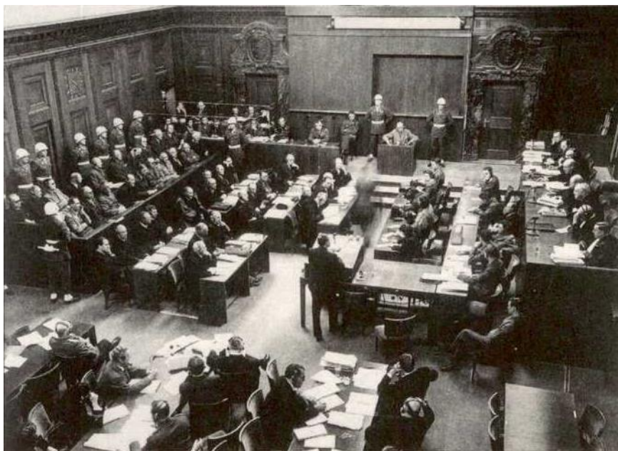
Blick in den Gerichtssaal im Nürnberger Justizpalast
