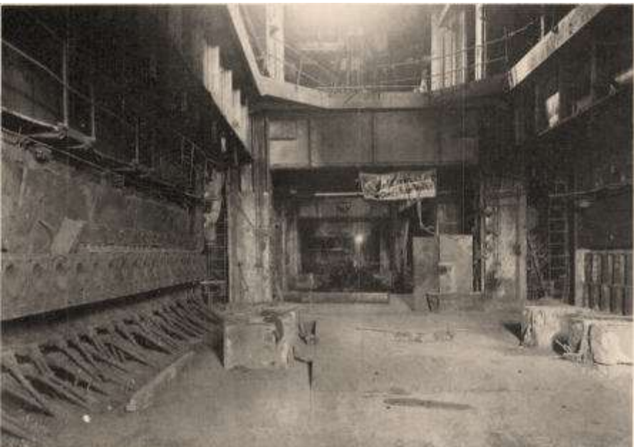
164 Das Kesselhaus des Kraftwerkes West nach der Demontage.
