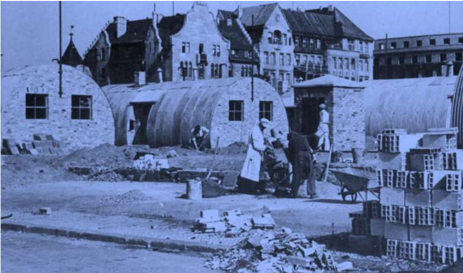
54 Nissenhütten am Bahnhof Hohenzollerndamm, nach englischem Muster gebaut als Ersatz für die zerstörten Wohnhäuser.
