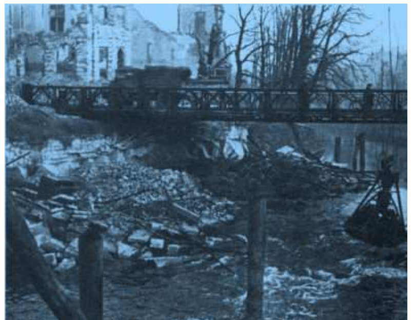
161 Eine Notbrücke über den Landwehrkanal ersetzt die zerstörte Herkules-Brücke. Im Vordergrund der Greifarm eines Baggers zur Wiederschiffbarmachung des Kanals.
