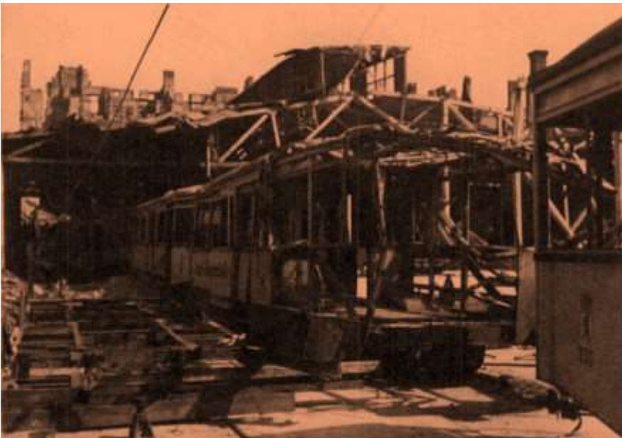
157 Der zerstörte Strassenbahnhof in der Kreuzbergstrasse.
