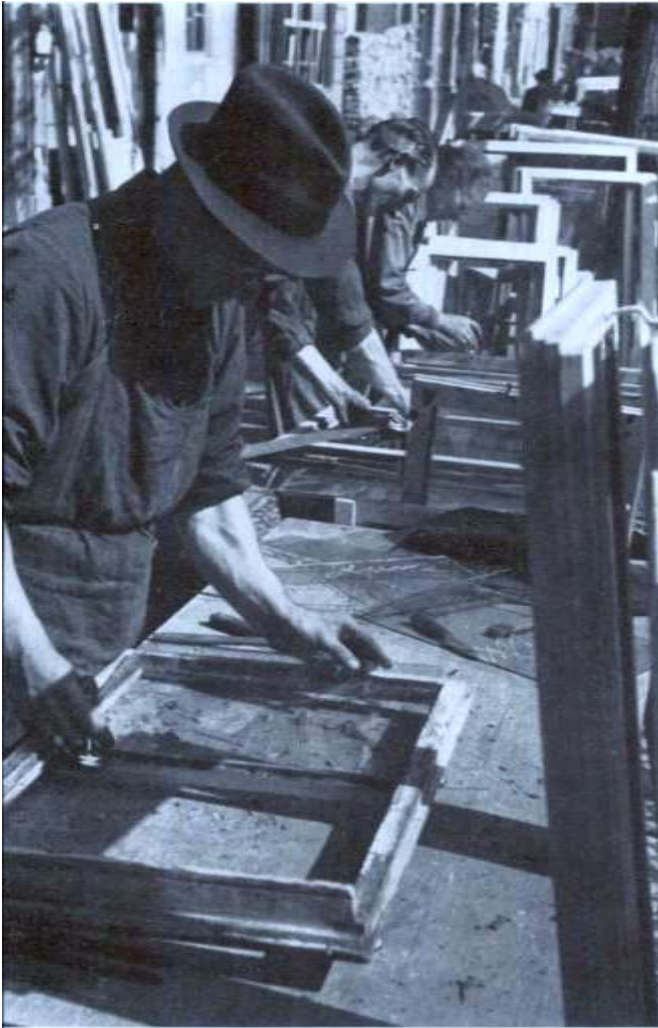
159 Eine Glaserwerkstatt im Freien: Bilder werden entrahmt und aus mehreren Scheibenteilen werden Fenster neu verglast. Fenster waren jetzt wichtiger als verglaste Bilder.
