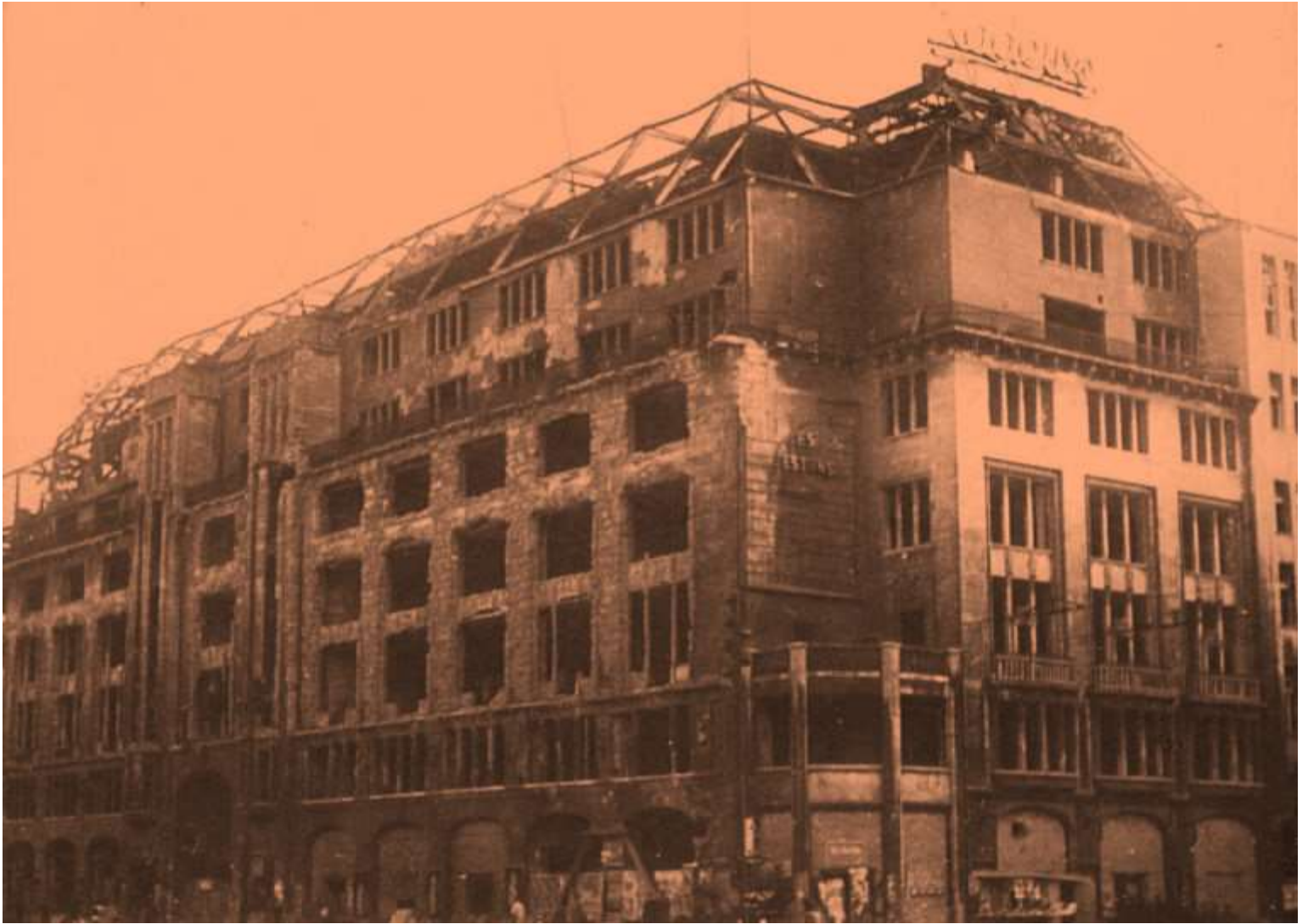
139 Das Kaufhaus des Westens, «KaDeWe», ist völlig ausgebrannt.
