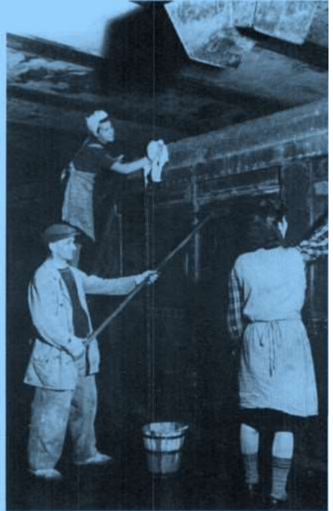
158 Instandsetzungs- und Säuberungsarbeiten an den Wagen der S-Bahn nach Rückgang der Überschwemmung im Juni 1945.
