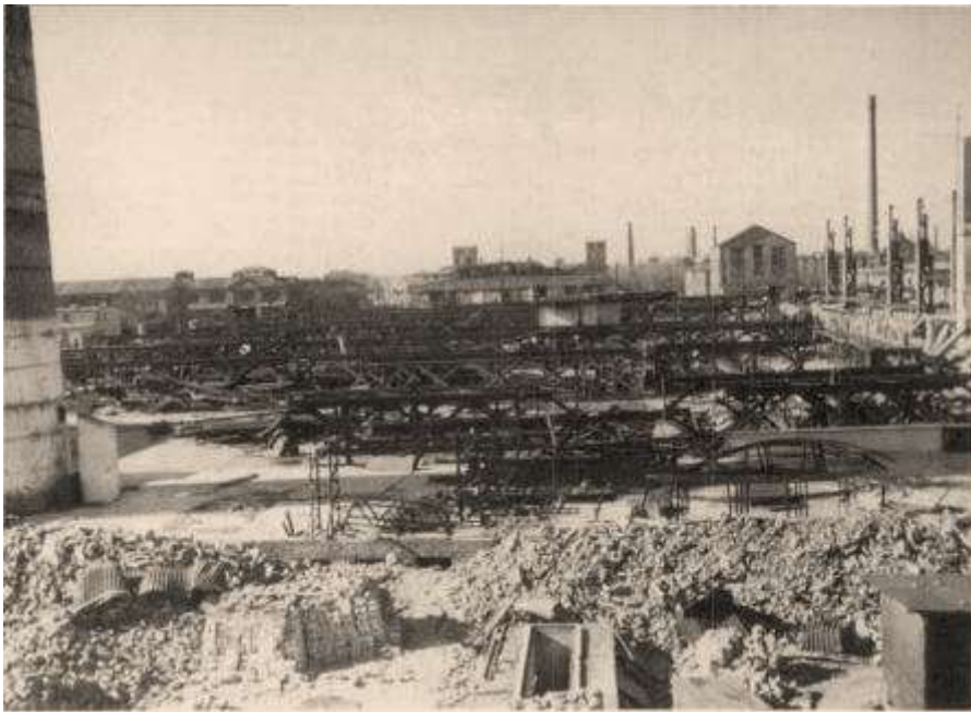
162/163 Die «Deutschen Werke» in Spandau während und nach den Demontagearbeiten, die auf Befehl der sowjetischen Militäradministration durchgeführt wurde.
