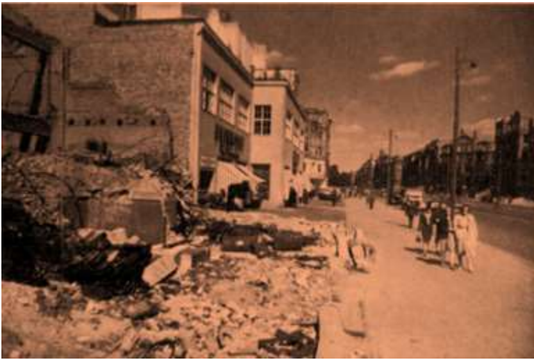
70 Die Berliner Prachtstrasse, der Kurfürstendamm (vom Bahnhof Halensee in Richtung Gedächtniskirche gesehen), wurde ziemlich bald entrümmert.
