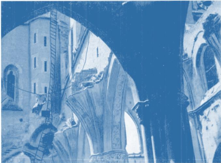
Die stark beschädigte Andrae-Kirche in Salzburg
