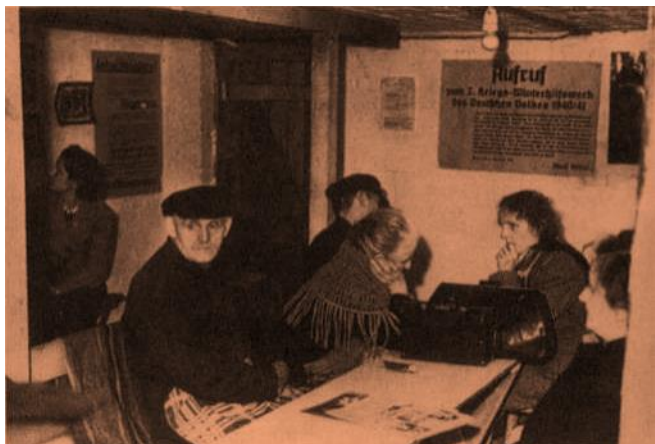
Ein provisorischer Luftschutzraum
