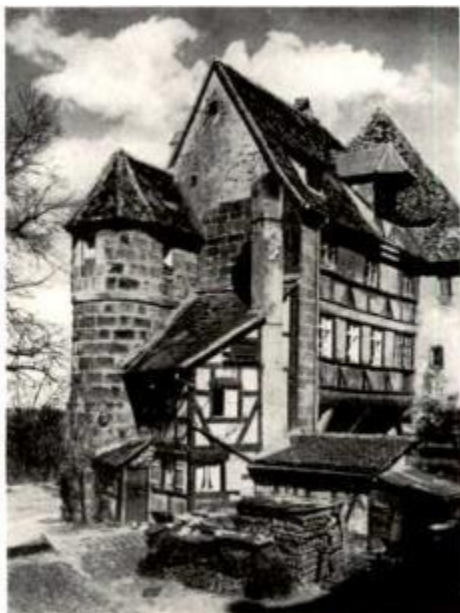
Nürnberg: Der Schwedenhof
