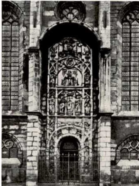
Chemnitz Portal der Schlosskirche
