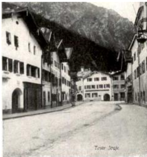
Bad Reichenhall Tirolerstrasse
