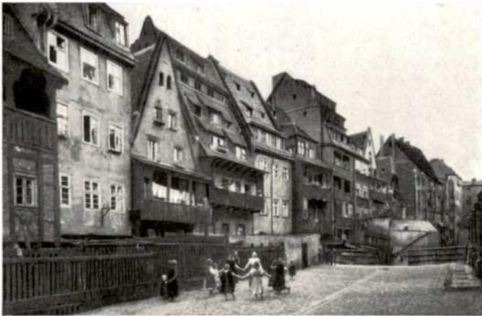
Breslau: An der alten Ohle
