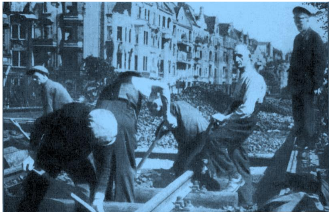
Wiederherstellung der U-Bahn in der Schönhauser Allee.
