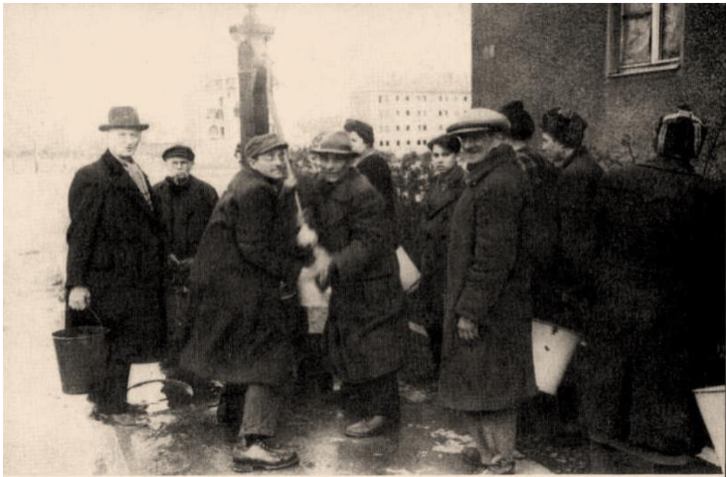
Strassenpumpen halfen nach der Einstellung der Trinkwasserversorgung die Wassernot lindern.
