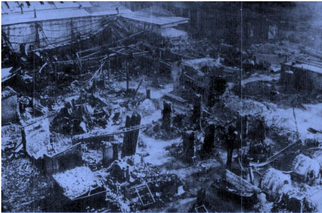
Zerstörte Werkanlage des zum AEG-Konzern gehörenden Kabelwerkes Oberspre.
