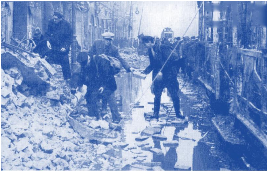
Die Hauptstadt nach dem Luftangriff vom 3. Februar 1945. Passanten beim Bau eines Notweges.
