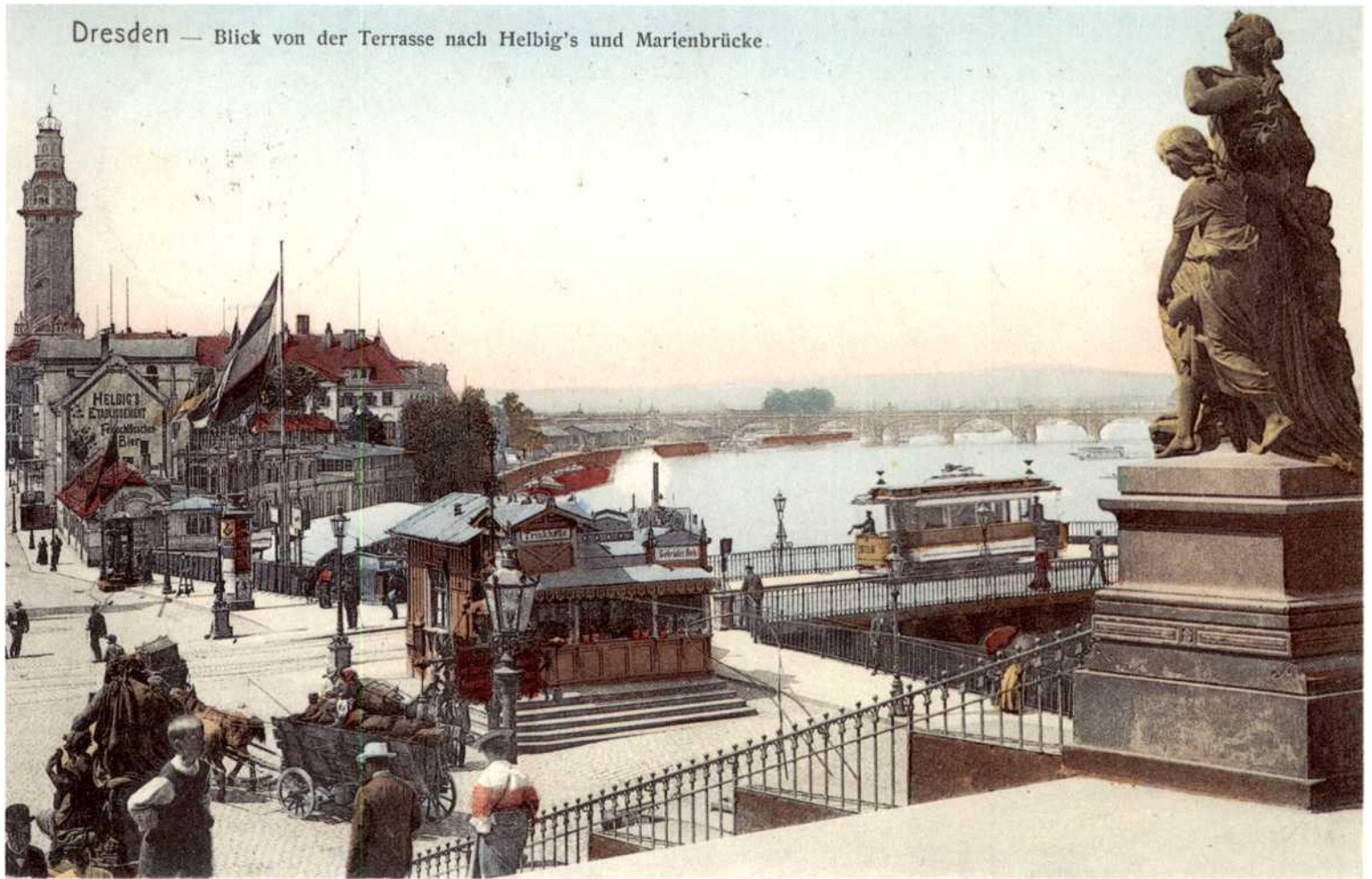
Links im Bild sehen wir den kunstvoll verzierten Schornstein des Fernheizwerkes, welches im Jahre 1900 fertiggestellt wurde.
