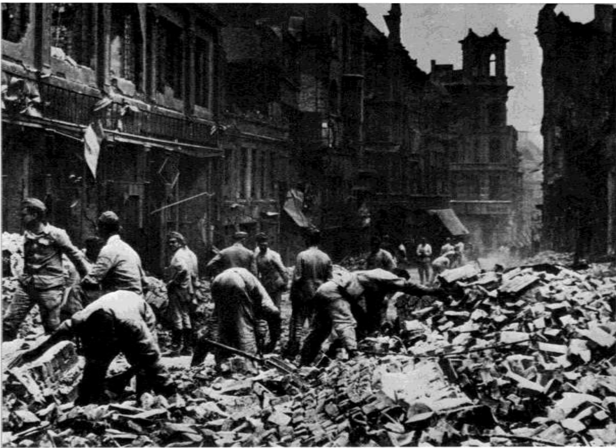
BILD 101 Wehrmacht-Kommando beim Freiräumen der Grossen Bergstrasse (Altona). Brocken für Brocken musste das geborstene Mauerwerk aufgenommen werden. Grosse Raumgeräte (z.B. Schaufel-lader) gab es damals noch nicht!
