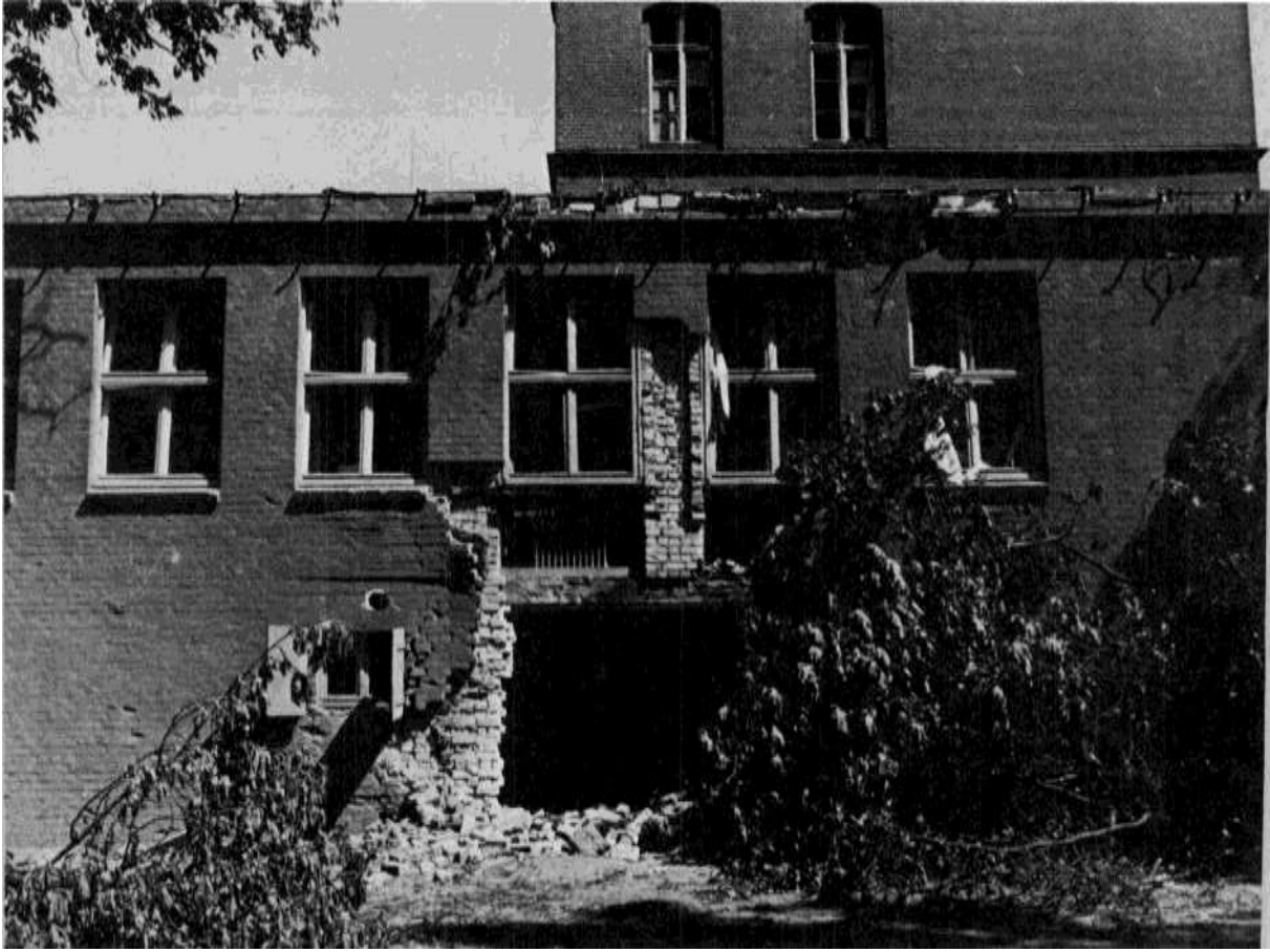
BILD 64 Naktrefter am splittersicheren Luftschutzraum Finanzamt Bergstrasse in Harburg – 18.5.1940.
