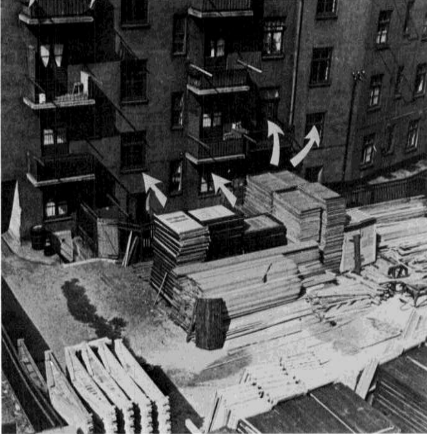
BILD 17 Lagerung von Barackenteilen im Wohngebiet. – Gefahr der Feuerübertragung auf die Wohnungen
