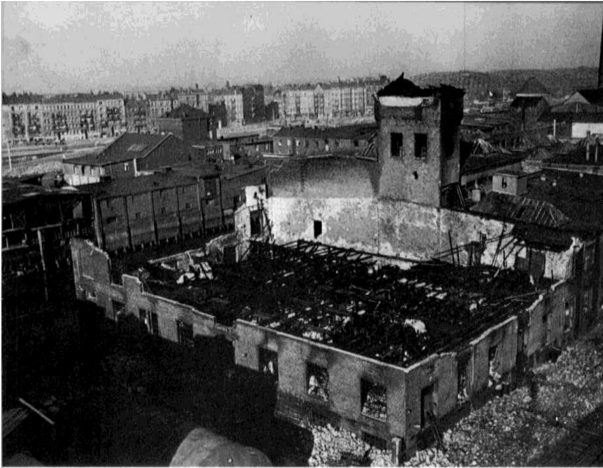
BILD 59 Die Brandstelle «Toepfers Ölwerke» auf der Peute am 3.2.1943 nach dem Dacheinsturz. Typisches Brandstellenbild nach einem Luftangriff!
