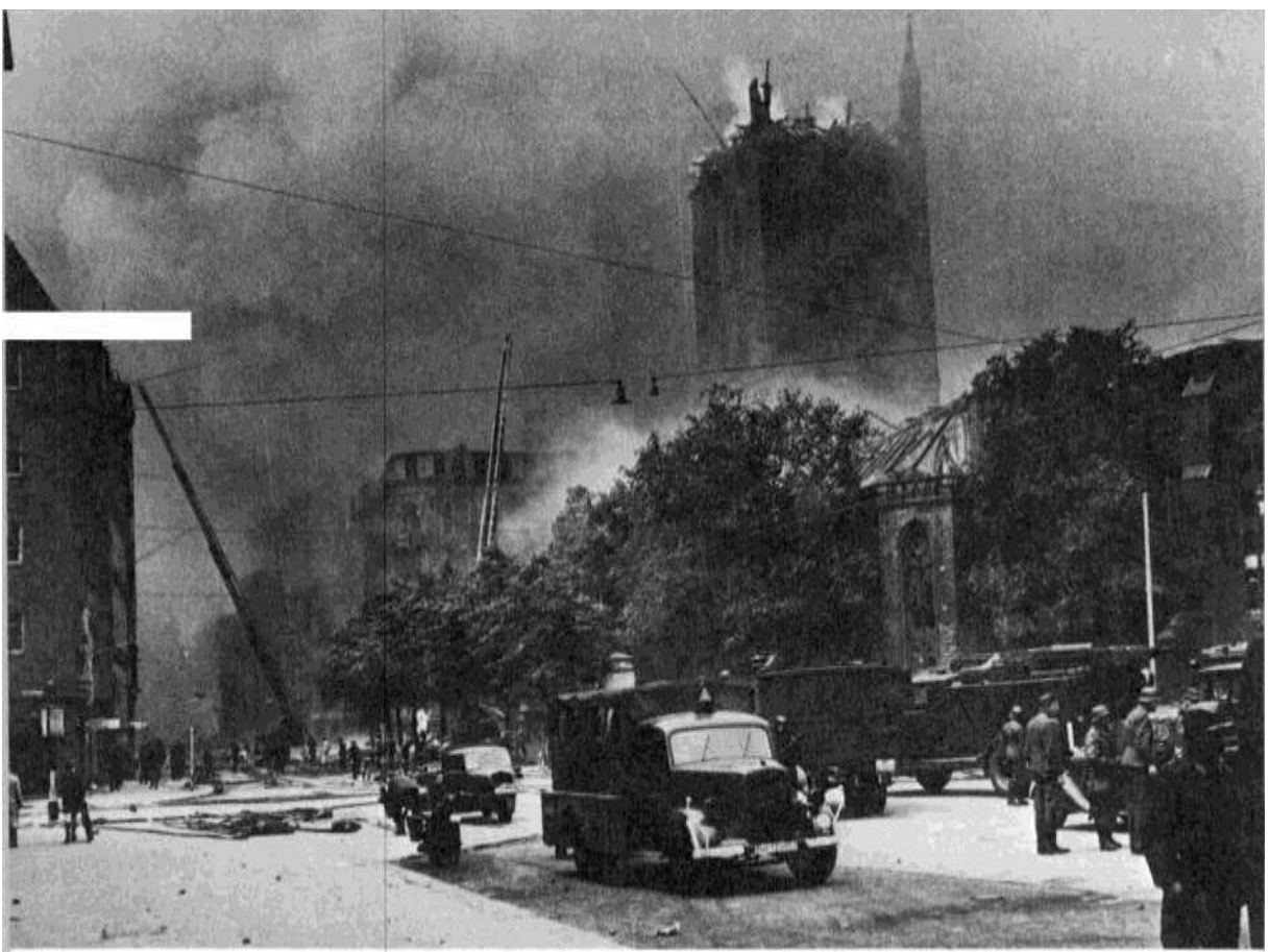
BILD 128 In der Steinstrasse nach dem Angriff am 18. Juni 1944. Der Turm der Jakobi-Kirche ist brennend eingestürzt, auch der Dachstuhl der Kirche ist abgebrannt. Löschkräfte bekämpfen Brände in den umliegenden Häusern.
