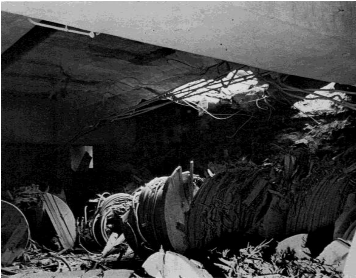
BILD 22 Wirkung einer 250 lbs-Sprengbombe im Kabelkeller der Hauptfeuerwache (14. März 1941).
