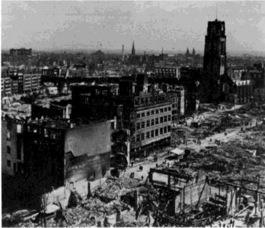
BILD 4 Rotterdam 1940: Übersicht des Hauptschadengebiets in der Altstadt; rechts der Turm von Saint Laurens (erbaut 1472).
