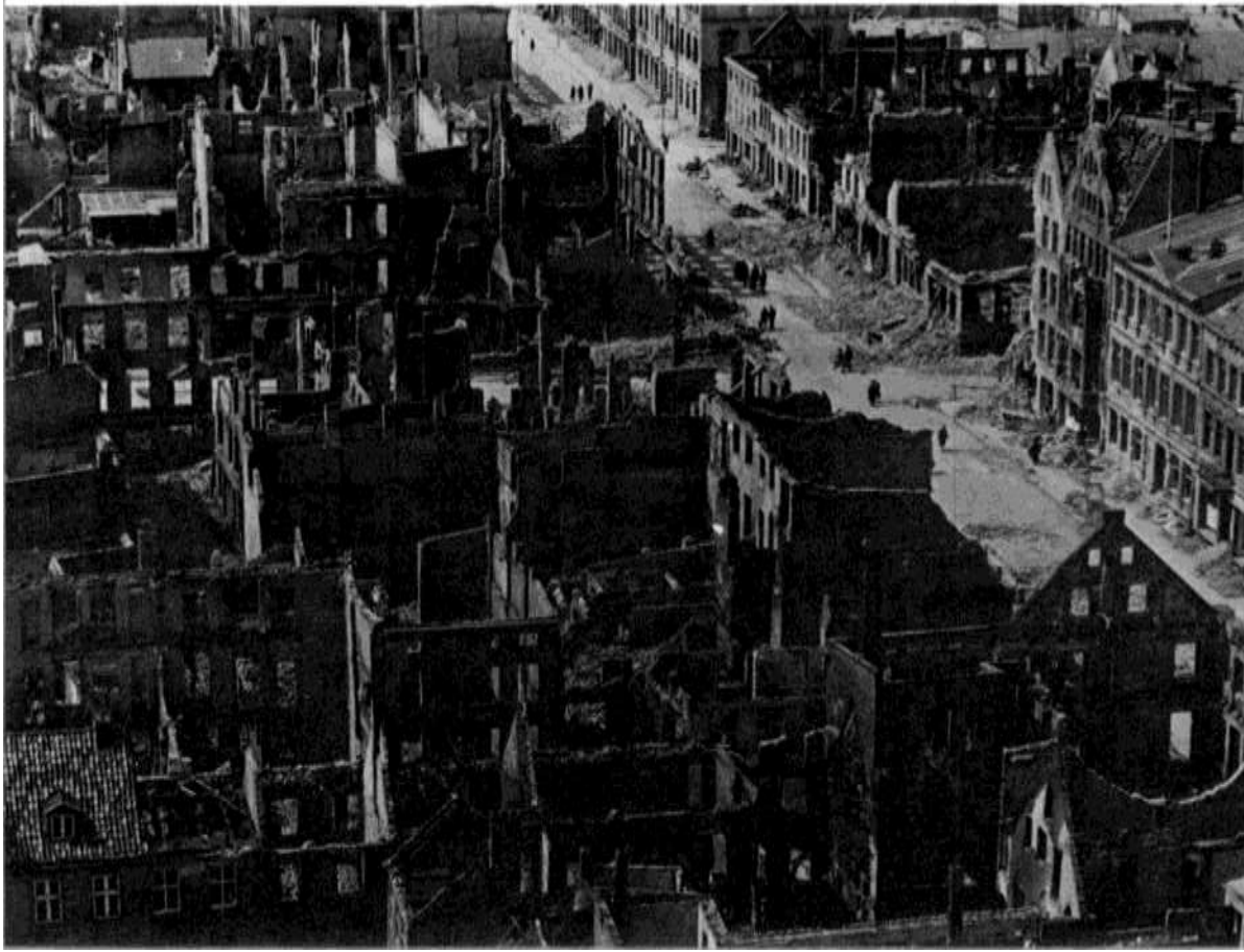
BILD 45 Blick von der Rostocker Marienkirche auf die ausgebrannte Innenstadt.
