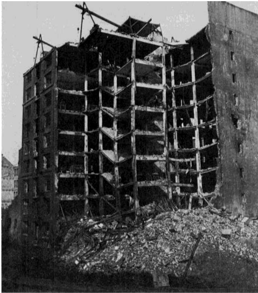
BILD 97 Ausgebrannte Ruine eines nach Sprengbombentreffer teilweise eingestürzten Speichergebäudes am Heidenkampsweg/Mittelkanal.
