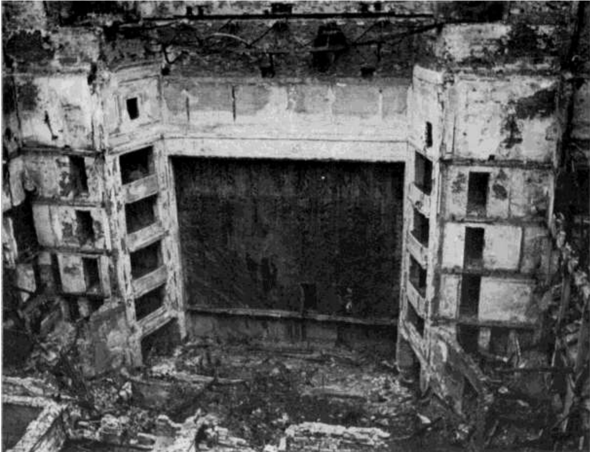
BILD 110 Hamburgische Staatsoper. Blick auf den eisernen Vorhang und den ausgebrannten Zuschauerraum. Aufgenommen von einer Drehleiter aus 25 m Höhe – August 1943.
