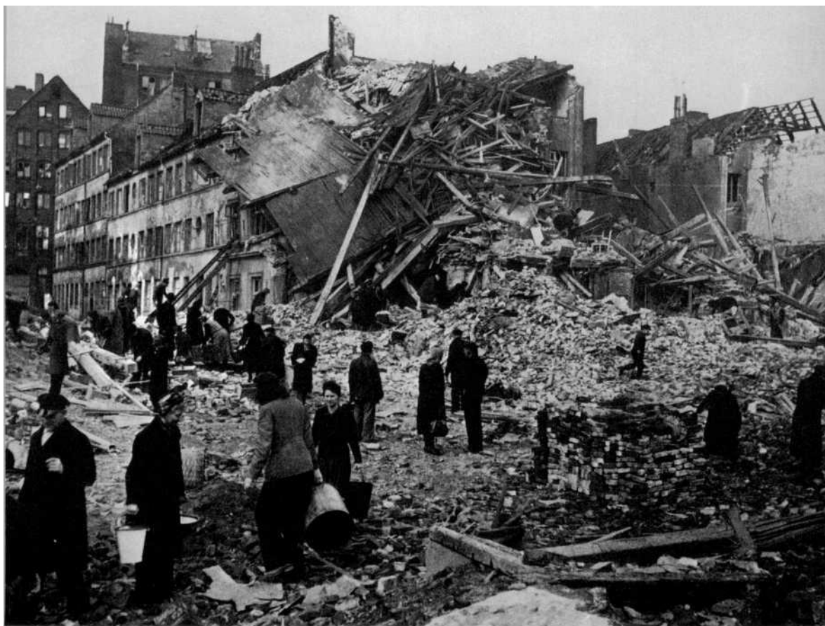
BILD 147 Zerstörungen in der Michaelisstrasse nach dem Angriff vom 11.3.1945.
