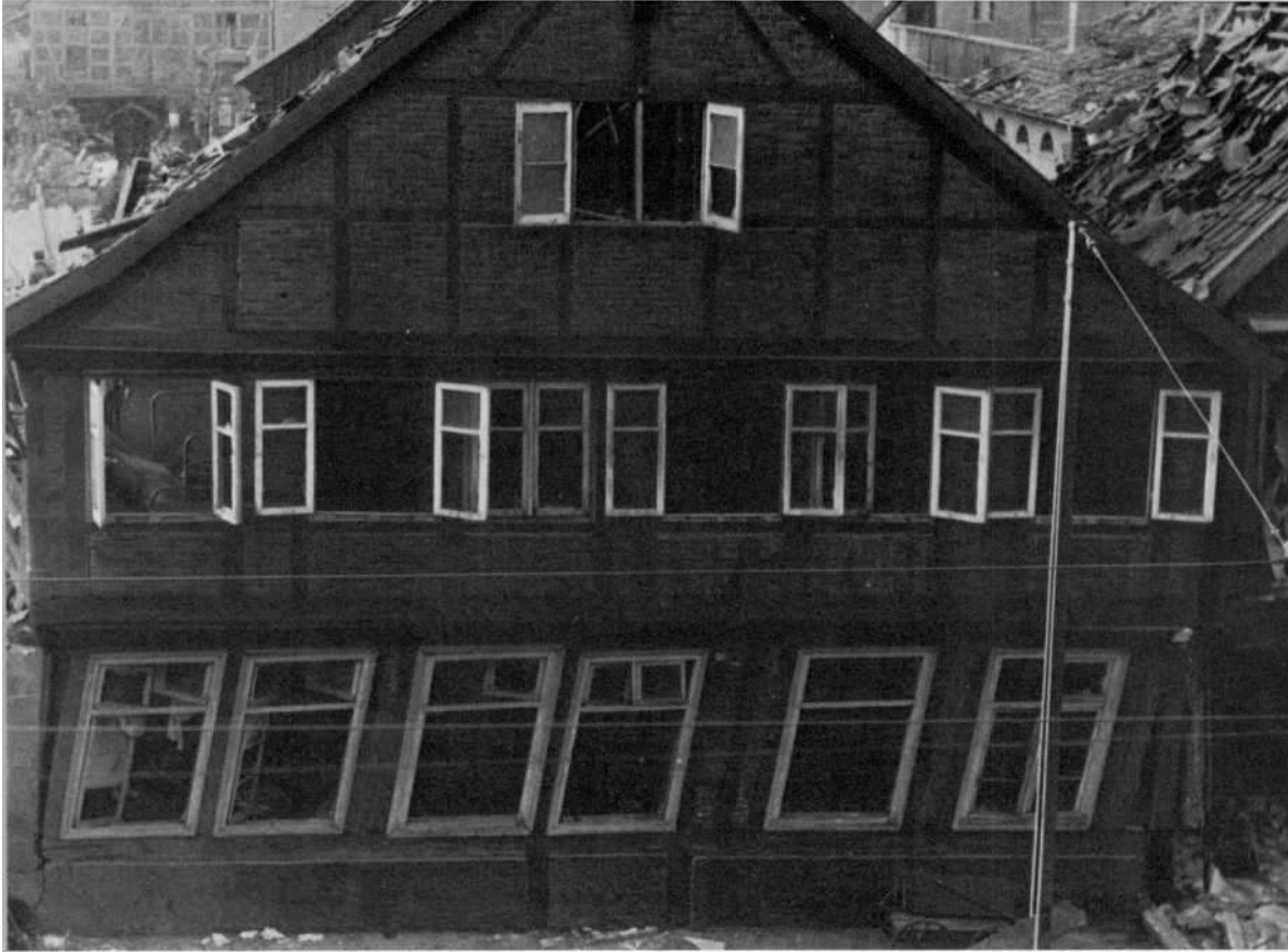
BILD 145 Harburg – Vorderfront eines Fachwerkhouses, die durch einen Sprengbombeneinschlag im rückwärtigen Gebäudeteil um über einen halben Meter seitlich versetzt wurde.
