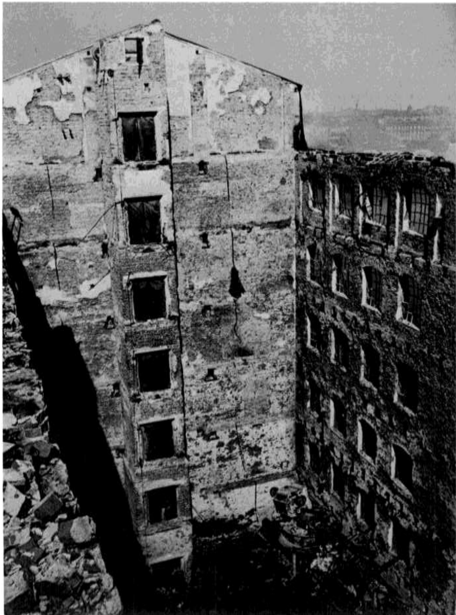
BILD 35 Blick in das ausgebrannte Haupt-Mühlengebäude. In Bildmitte der Aufzugsschacht.
