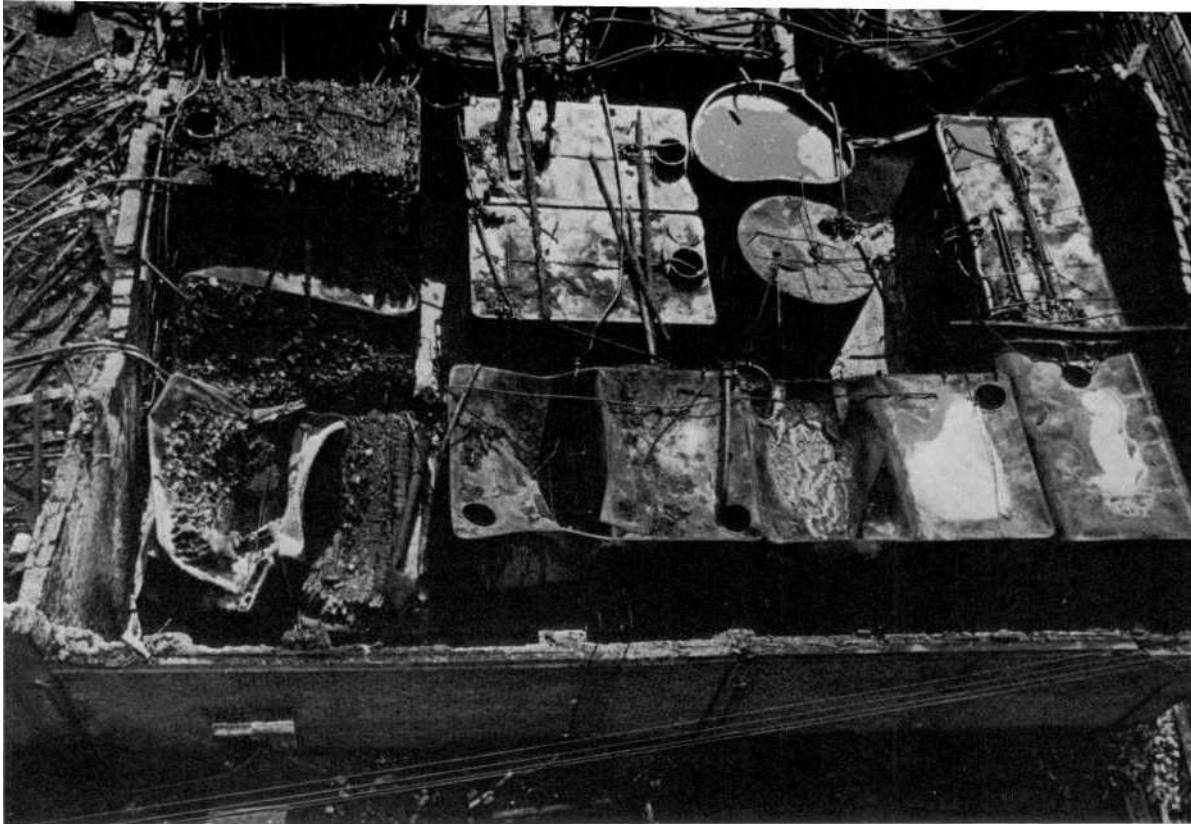
BILD 27 Teilweise ausgebrannte Öltanks bei den Deutschen Erdölwerken. Die Behälter standen auf Stützen und wurden von unten aufgeheizt.
