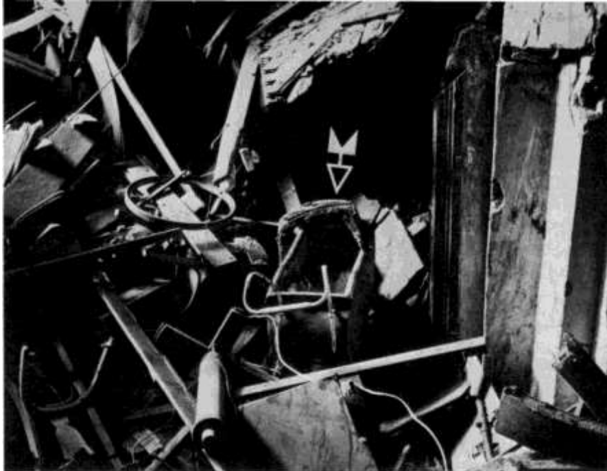
BILD 11 Café Baur am Steindamm – 5. Juli 1940 Pfeil: Der Babywagen im Luftschutzkeller!
