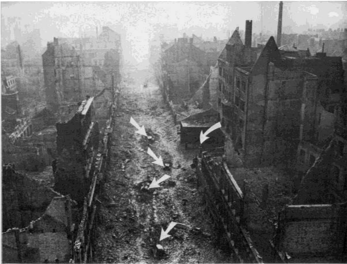
BILD 84 Der Steindamm – gesehen von der Ecke Berliner Tor/Lohmühlenstrasse in Richtung Hauptbahnhof mit den 10 verschütteten, ausgebrannten Fahrzeugen der FE-Bereitschaft 2./X. In Bildmitte das «Pfennig-Denkmal» vor der Zweigstelle der Hamburger Sparkasse von 1827. Aufgenommen von einer Drehleiter aus 25 m Höhe am 29.7.1943.
