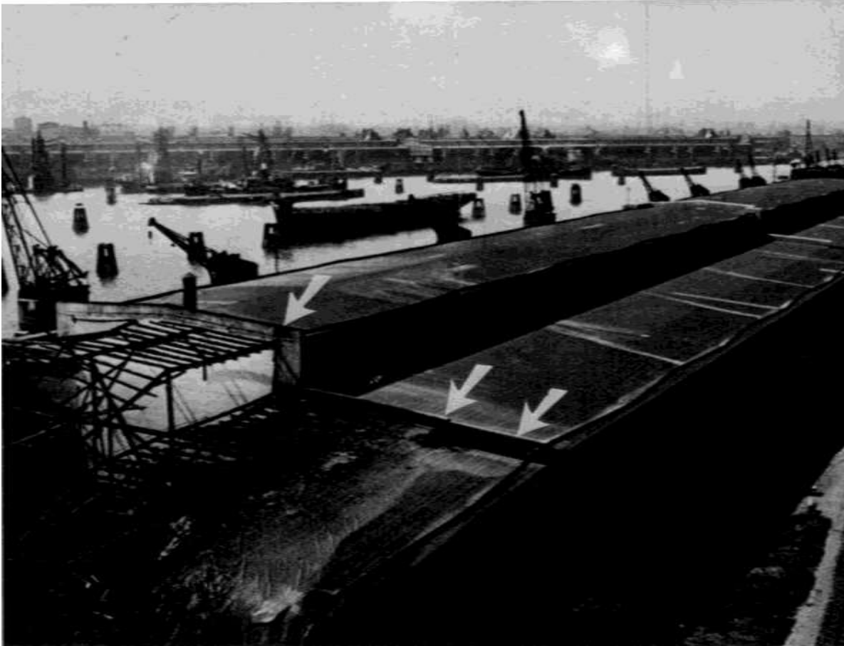
BILD 49 Schuppen 43 A – durch Brandmauern vor der Zerstörung bewahrt (Pfeile!) – 4.5.1942.
