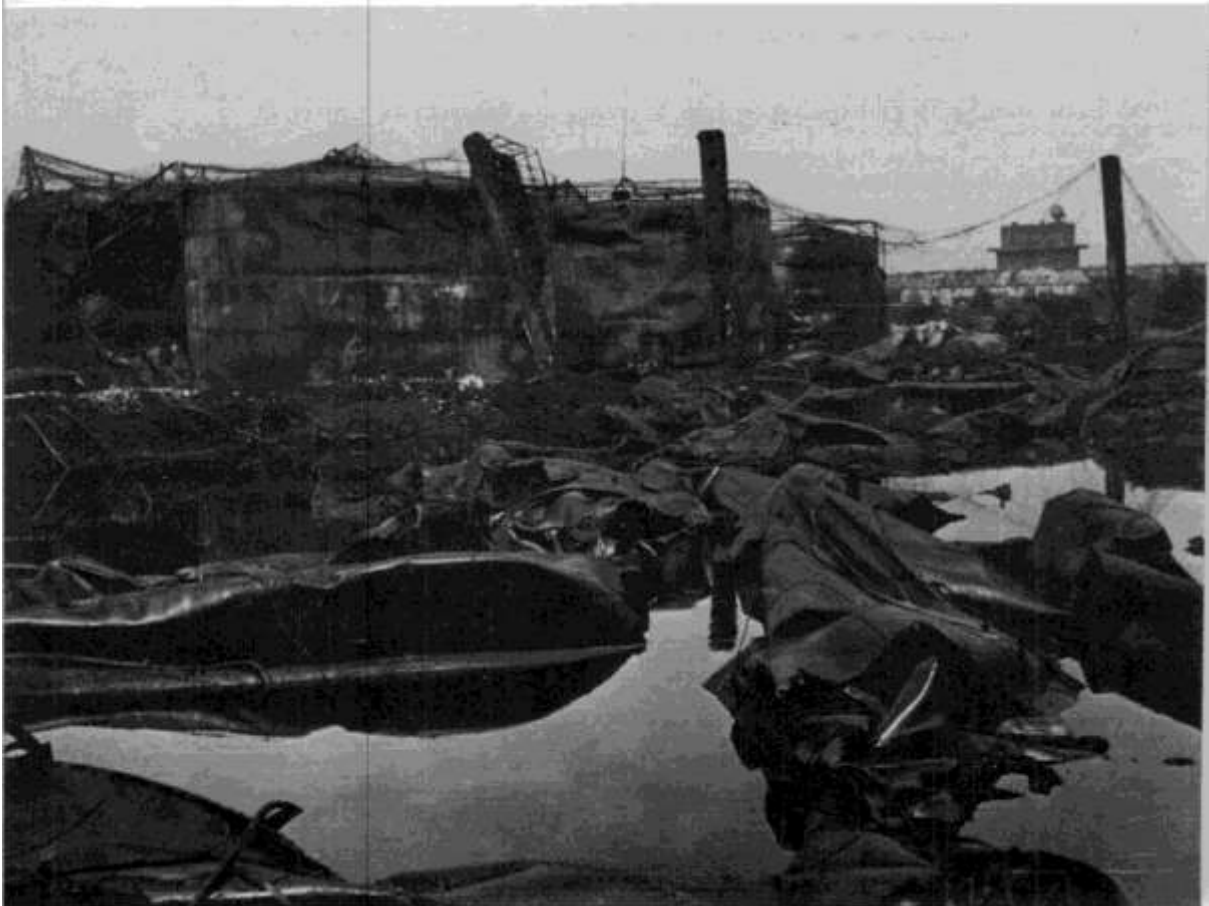
BILD 142 Ausgebranntes Tankfeld bei den Deutschen Erdölwerken in Wilhelmsburg – 6.8.1944. Die Raffinerie ist nach dem Kriege nicht wieder aufgebaut worden.
