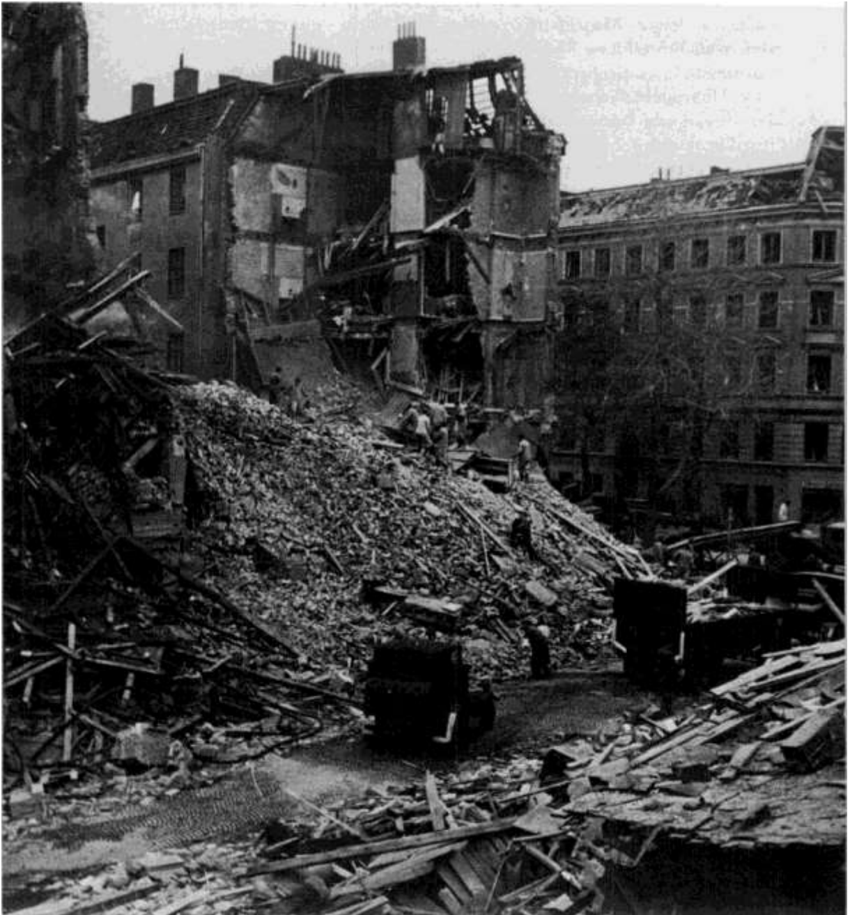
BILD 26 Teilansicht der Minenbomben-Einschlagstelle Tieloh/Bramfelderstrasse.
