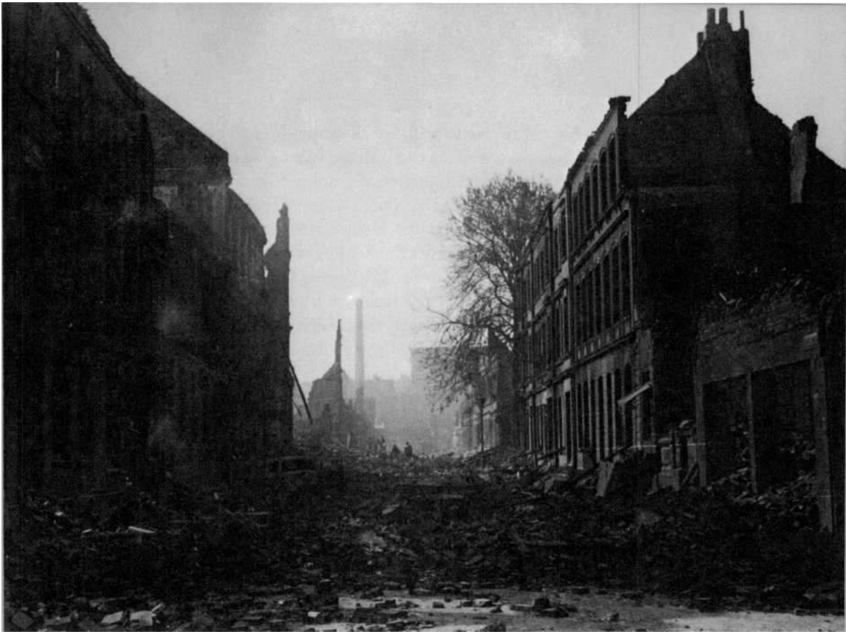
BILD 69 Ausgebrannter, verschütteter Strassenzug in Eimsbüttel – Gärtnerstrasse.
