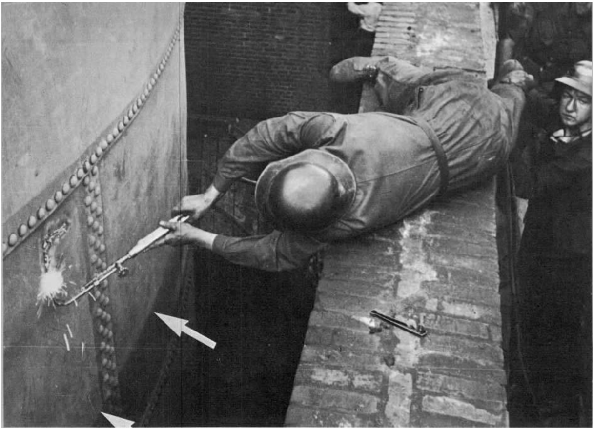
BLD 138 Einschneiden eines Lochs (etwa 20x40 cm) in die Wand eines brennenden Tanks zum Einführen eines Schaumrohrs. Pfeile: Stand des Flüssigkeitsspiegels. – 6.8.1944.
