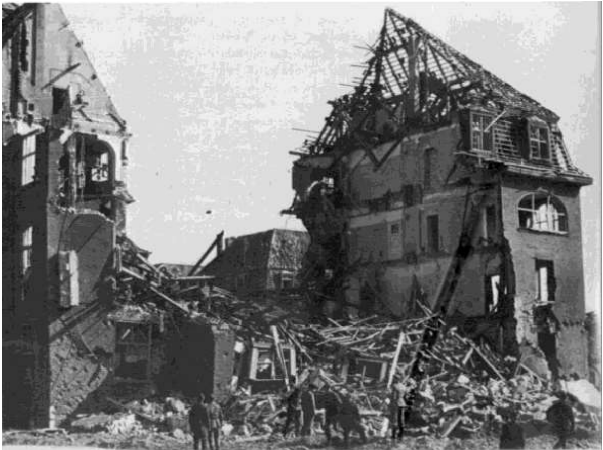
BILD 131 Das zerstörte Wachgebäude der Hauptfeuerwache Berliner Tor (18.6.1944).
