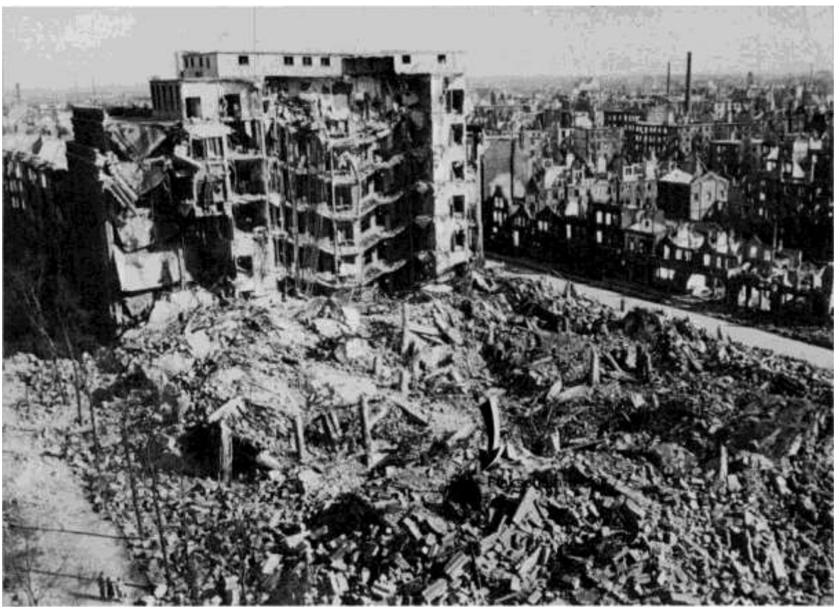
BILD 106 Das Karstadt-Gebäude nach dem Angriff. Aufnahme von einer Drehleiter aus 25 m Höhe Mitte August 1943.
