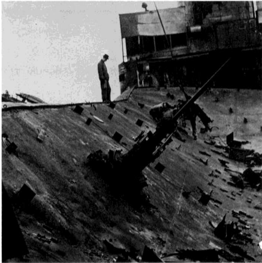
BILD 24 Sonnendeck der «Bremen» nach dem Brande. Flakgeschütze, Munitionskästen und Geschosshülsen auf den eingesunkenen Decksplatten.
