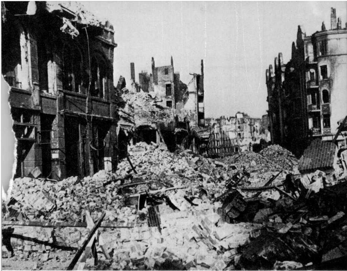
BILD 151 Die Strasse «Hohe Bleichen» – Blickrichtung «Grosse Bleichen» – nach dem Angriff vom 8.4.1945.
