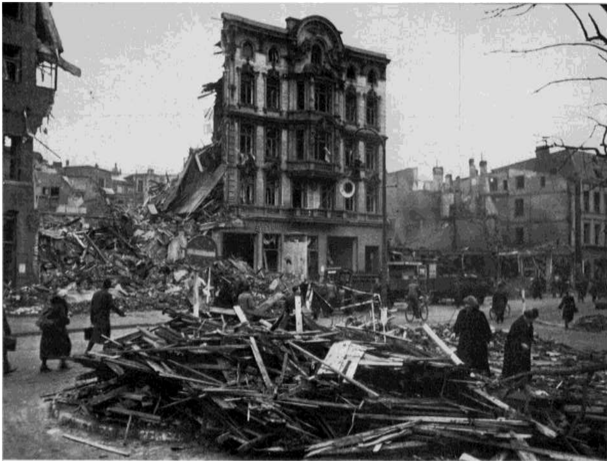
BILD 143 Harburg – Blick auf die Wilstorfer Strasse nach den Oktober/November-Angriffen 1944.
