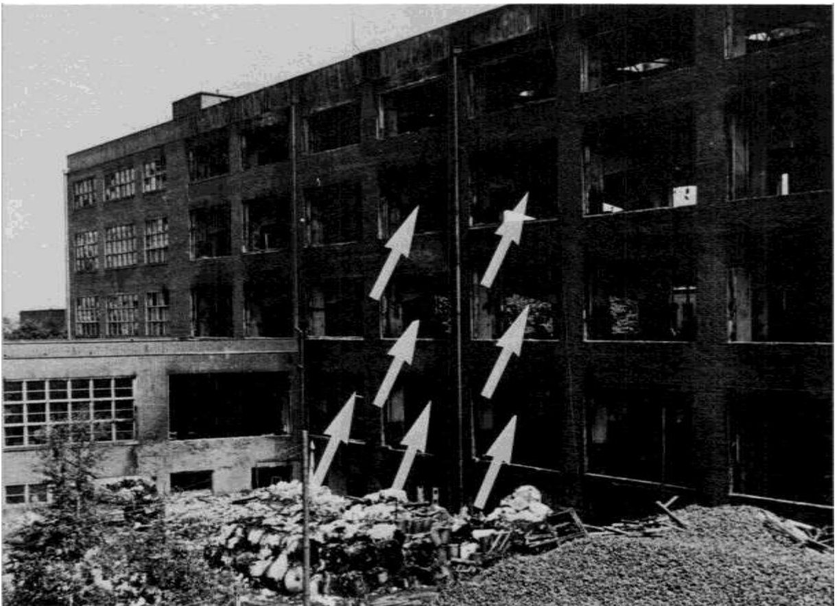
BILD 52 Hanseatische Verlagsanstalt, Bramfelder Strasse, von einem brennenden Holzschuppen (Pfeile) entzündet – 27.7.1942.
