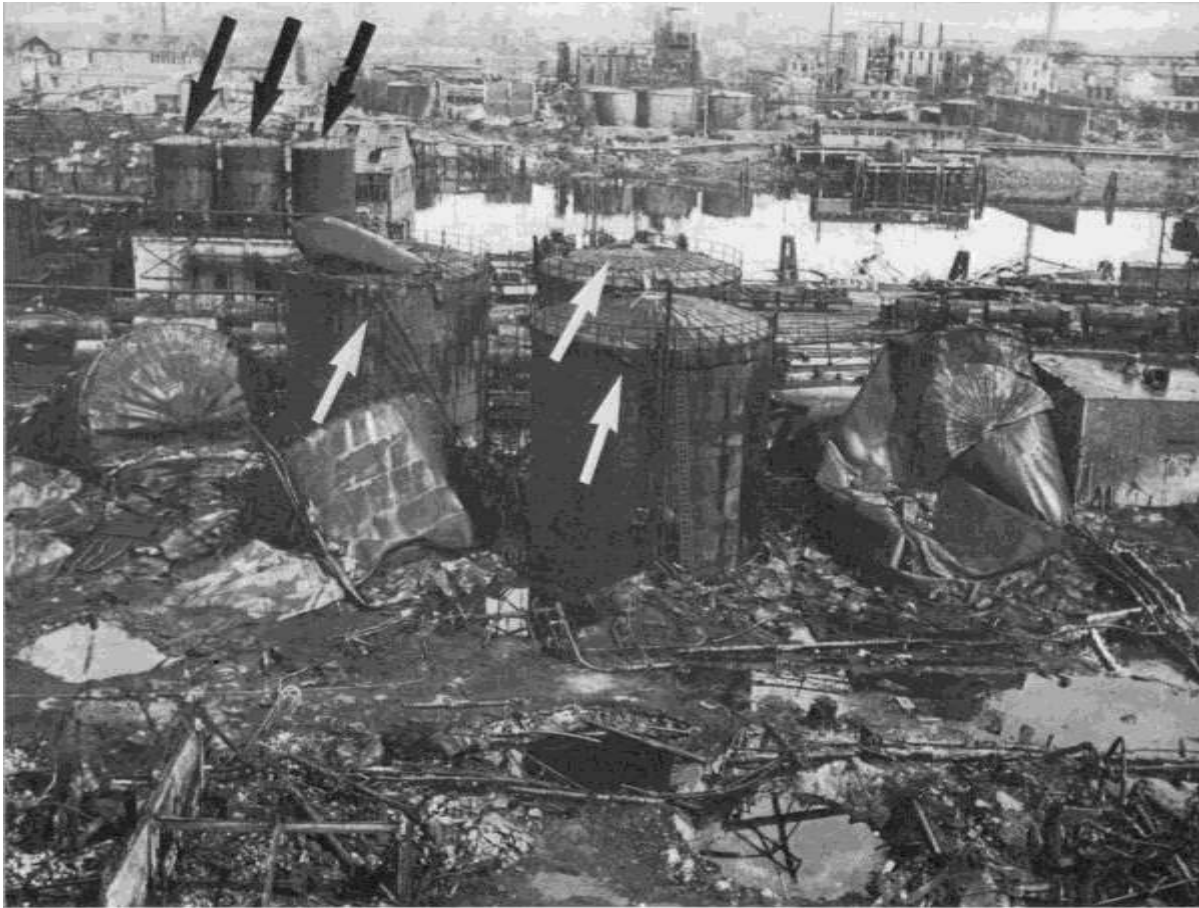
BILD 137 Die Ebano-Asphalt-Werke Harburg nach dem Angriff vom 20.6.1944. Im Hintergrund die Rhenania-Ossag-Raffinerie. Einige Tanks (Pfeile!) sind noch erhalten.
