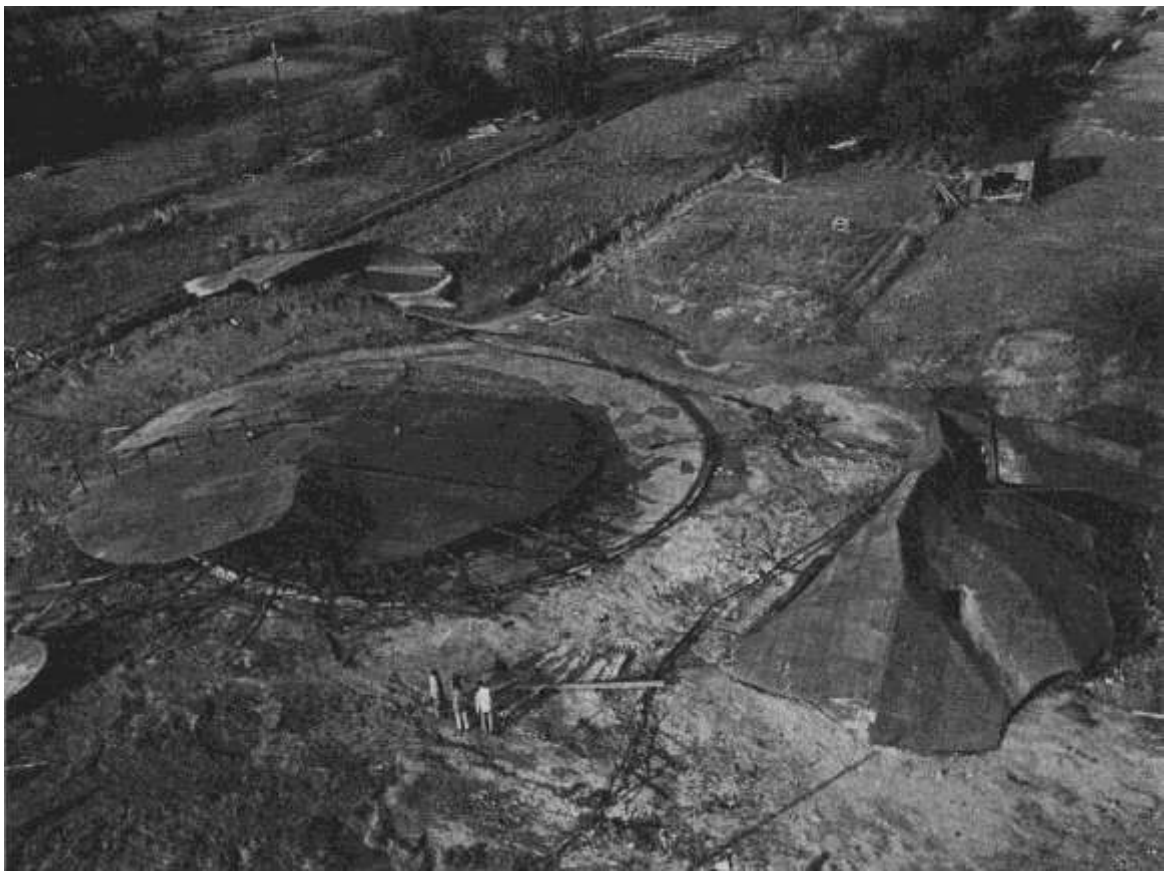
BILD 16 Geborstener 6.000 m 3 -Mineralöltank in Warwisch – 19. Oktober 1940.
