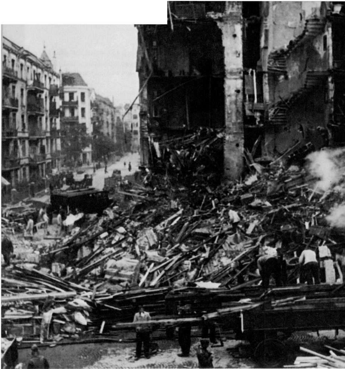
BILD 39 Teilansicht der Minenbomben-Einschlagstelle Wielandstrasse – 16. September 1941. Beachte die ungeheuren Holzmenngen der auf gerissenen Fussböden und Decken!
