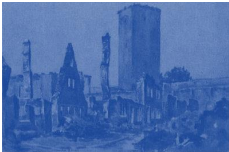
Wengasse am 7. Oktober 1945. Bild einer geschlagenen Stadt. Die ausgebrannte Wehrmauer umschliesst sie noch. Kamine recken sich ängstlich zur Höhe. Menschen, die mit ihren Kindern in diesen Häusern ihr Brot teilten, sind tot oder haben mit ihren Lieben die Stätte des Grauens verlassen.
