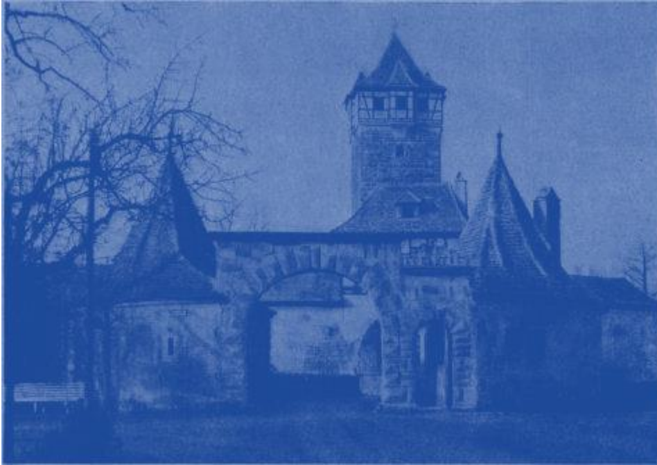
Der Röderturm gehört mit der wiederergänzten Röderbastei und dem in seiner ursprünglichen Reinheit erstrahlenden geschlossenen Hof des Vorwerks (Barbigan) zum Erfreulichsten, was seit 1945 wieder erstanden ist. Er ist wieder Dominante im geschlossenen Mauer- ring.
