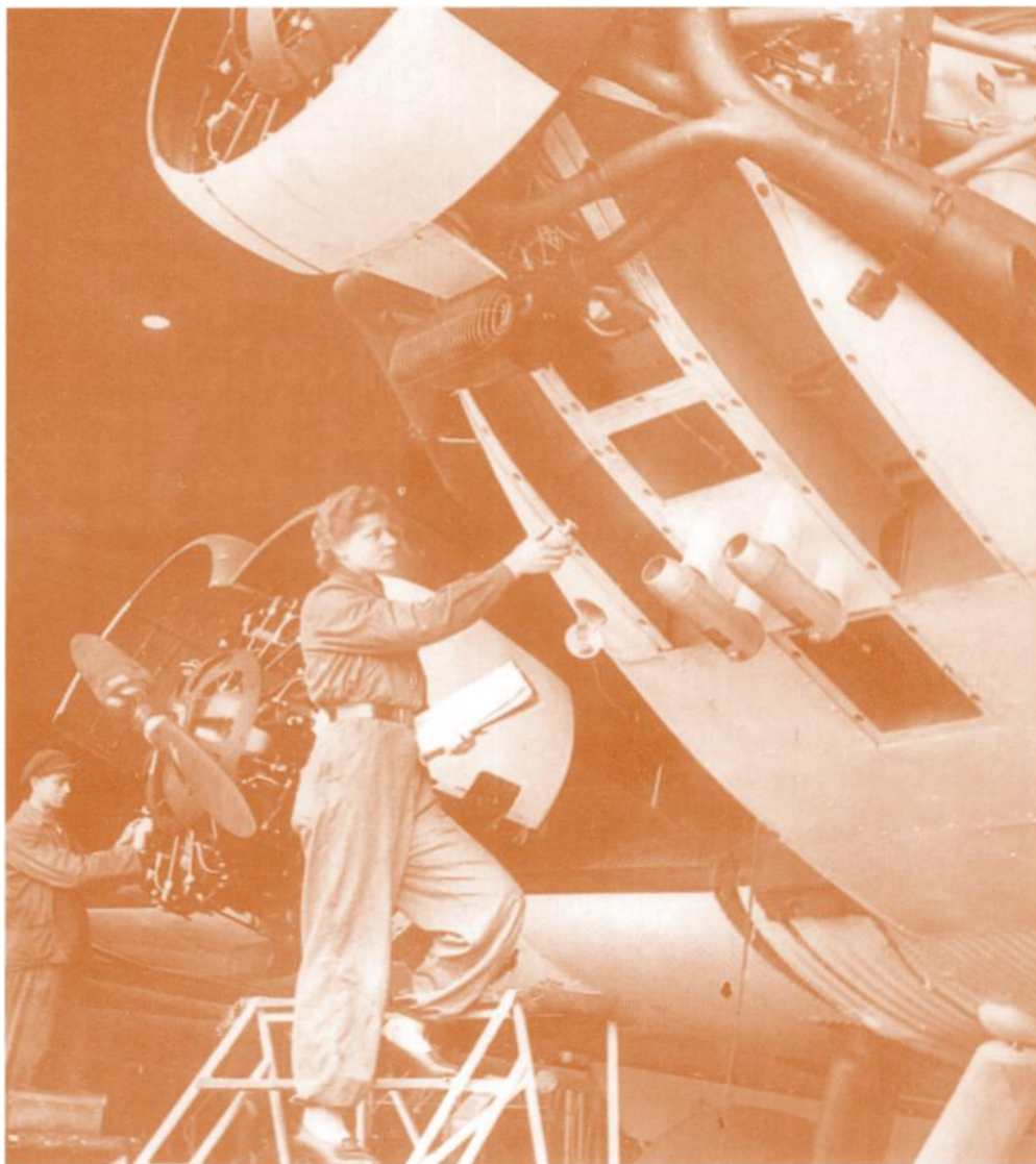
Frauen leisten Männerarbeit im Flugzeugbau. Anhand einer Liste überprüft diese junge Arbeiterin nach der Fertigmontage die einzelnen Einbauteile einer Ju 52. PK-Foto
