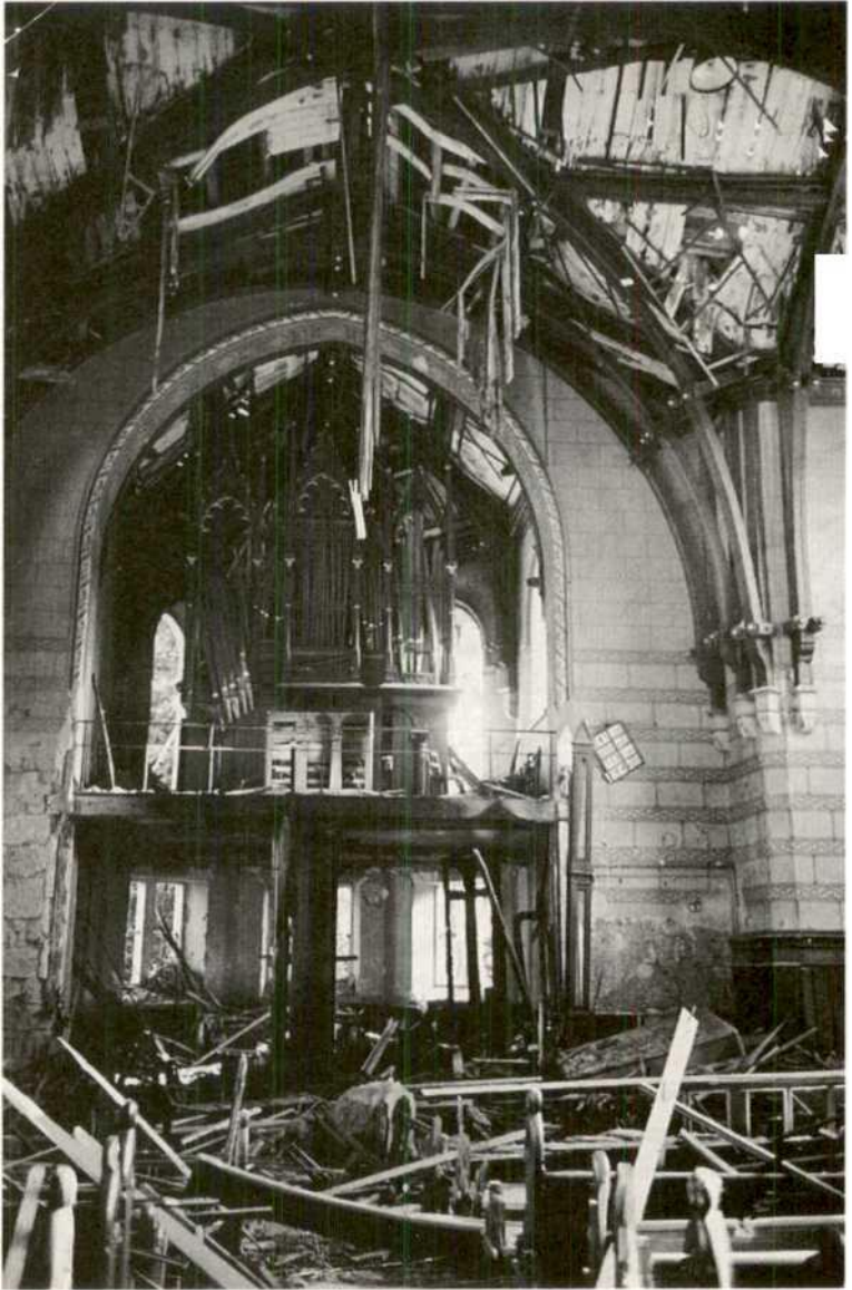
Innenansicht der Steigkirche
