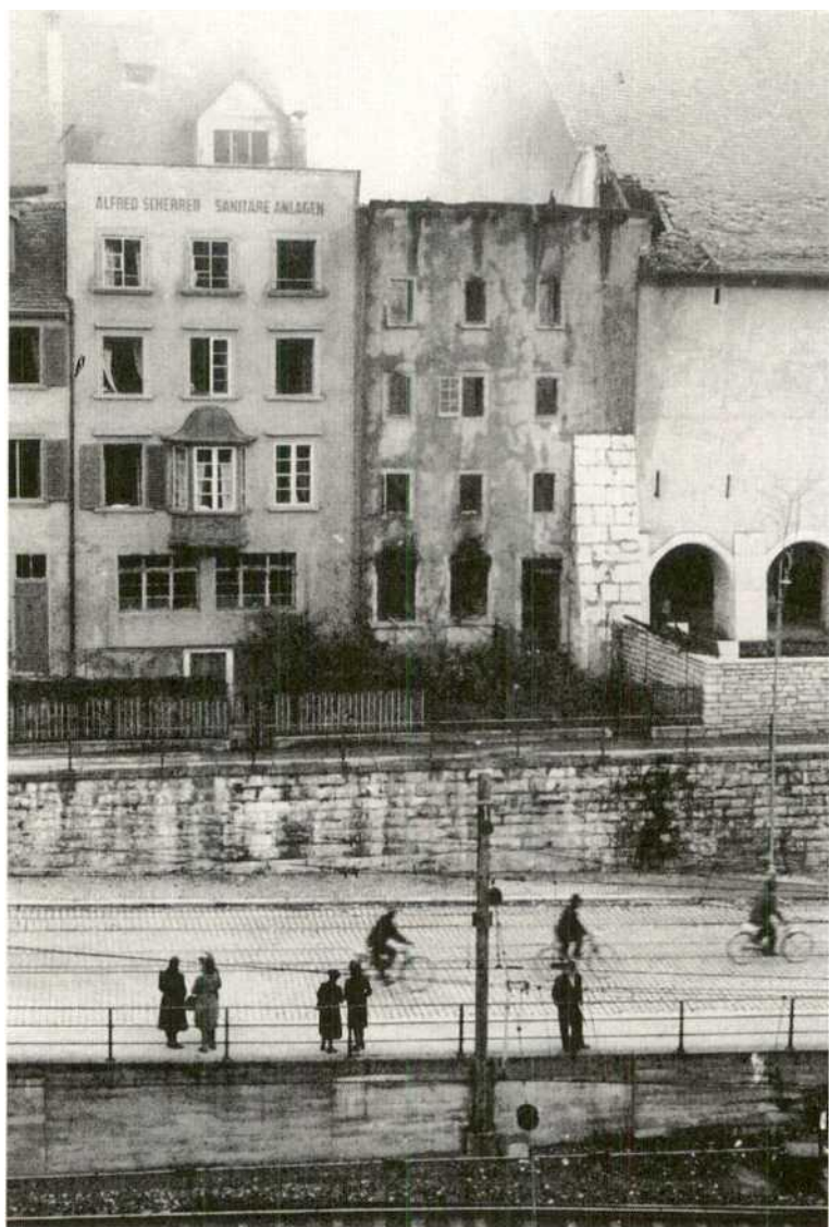
Grabenstrasse mit ausgebranntem Haus zur Landkutsche
