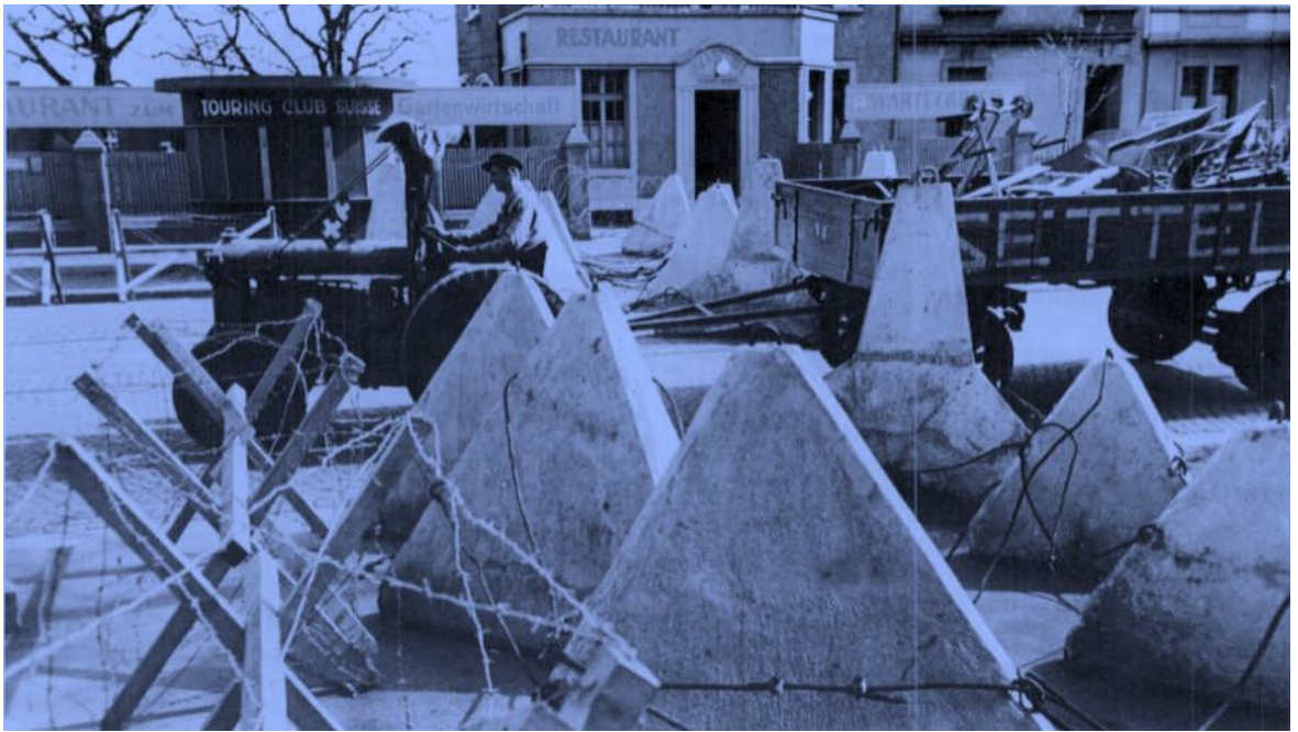
Vorbereitete Sperren in den Strassen von Basel, 1945
