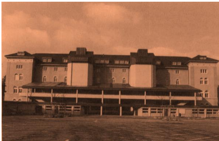
... während auf der Südseite (Kasernenhof) sogenannte Annexbauten mit Büros, Putzhallen und zwei Treppenhäusern die alten «WC-Türme» ersetzen.
