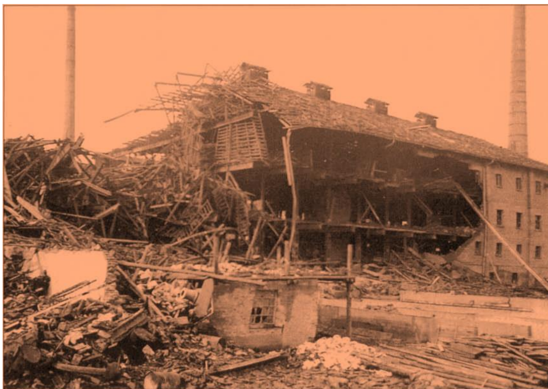
Das Tonwerk in Thayngen wurde vollständig zerstört. Zum Glück war Sonntag, und die beiden einzigen anwesenden Arbeiter waren zufällig an einem geschützten Ort.
