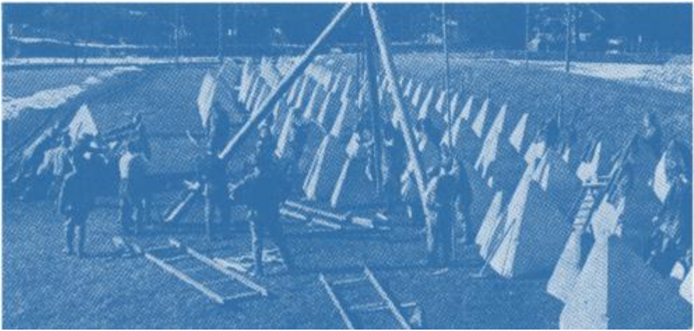
Die Armee baut Tanksperren, Bunker, Unterkünfte, Geschützstellungen.
