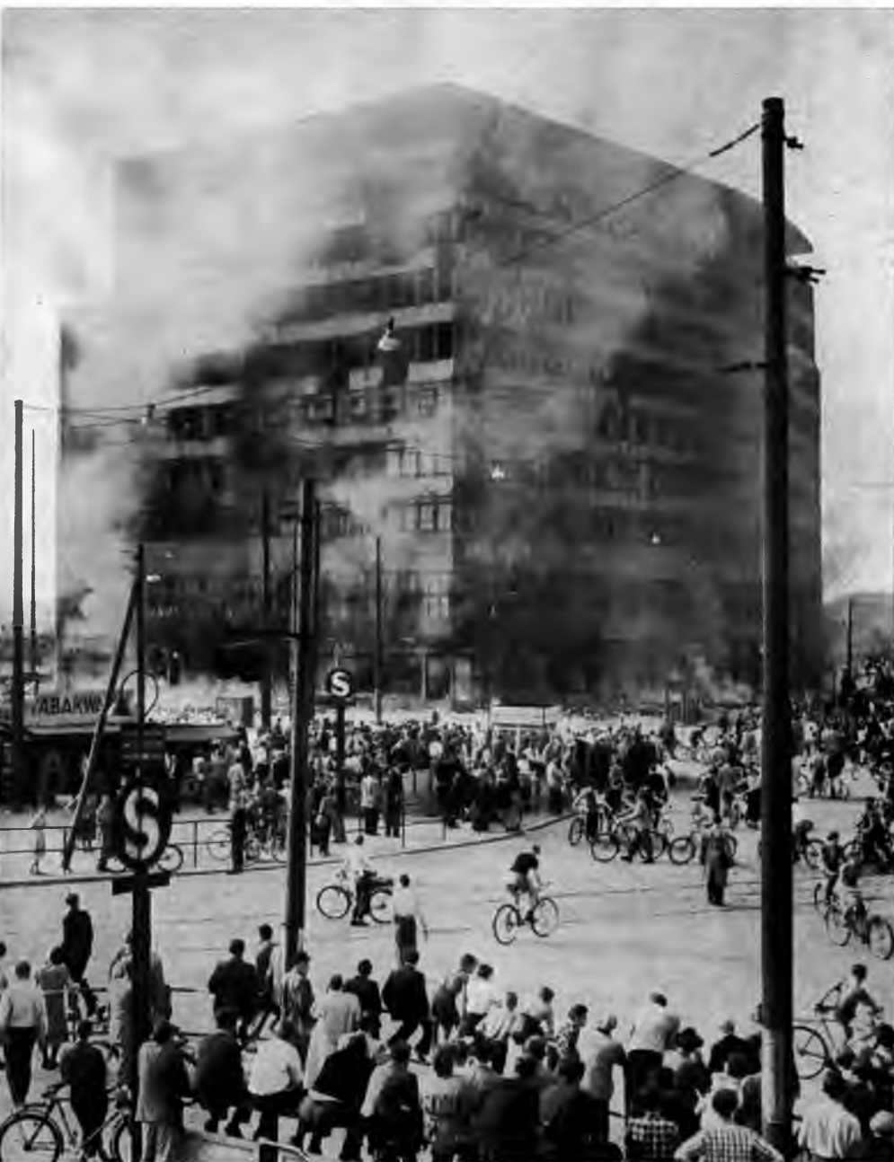
RAUCHSCHWADEN ziehen in den Abendstunden des 17. Juni 1953 über den Potsdamer Platz. Von Aufständischen ist das Columbushaus an der Sektorengrenze in Brand gesetzt worden. Morgens hatte die hier stationierte Volkspolizeiwache vor den Demonstranten kapituliert und die weiße Flagge gehißt.
