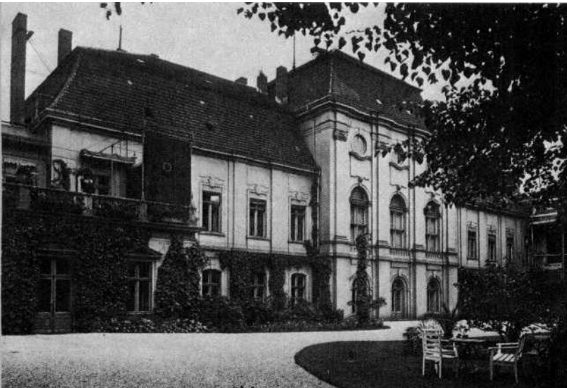
Gartenfront der Alten Reichskanzlei in der Wilhelmstrasse. Die Ernennung und Vereidigung Hitlers zum Reichskanzler am 30. Januar 1933 fand in diesem Hause statt - hinter den drei Fenstern links im ersten Stock - weil gerade in diesen Wochen das Reichspräsidentenpalais renoviert wurde.
