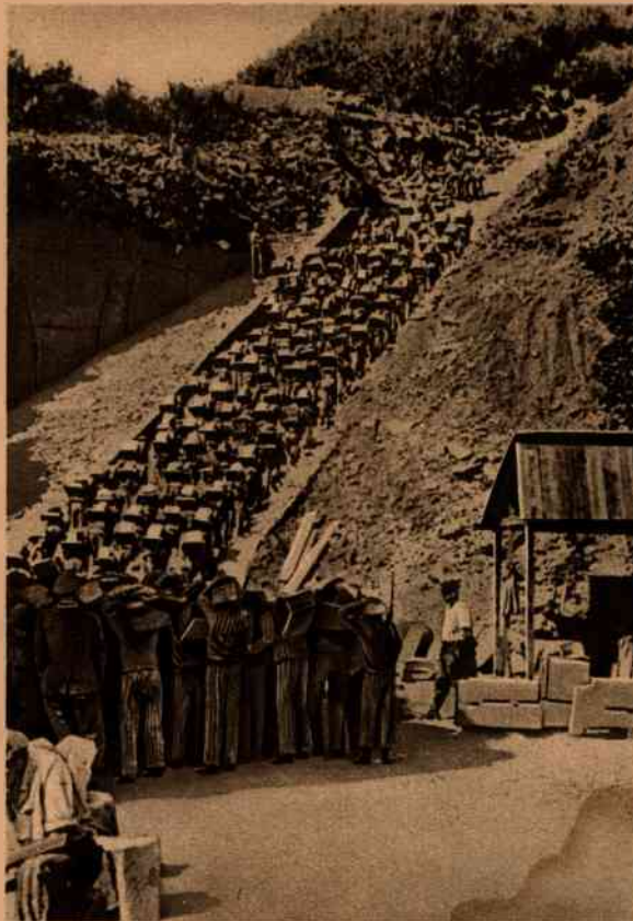
KZ-Häftlinge im Steinbruch des Konzentrationslagers Mauthausen. In diesem Steinbruch wurden Tausende von Antifaschisten ermordet.
