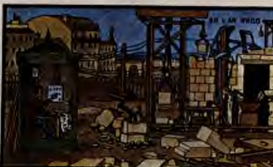
Chantier de Construction électrique.
