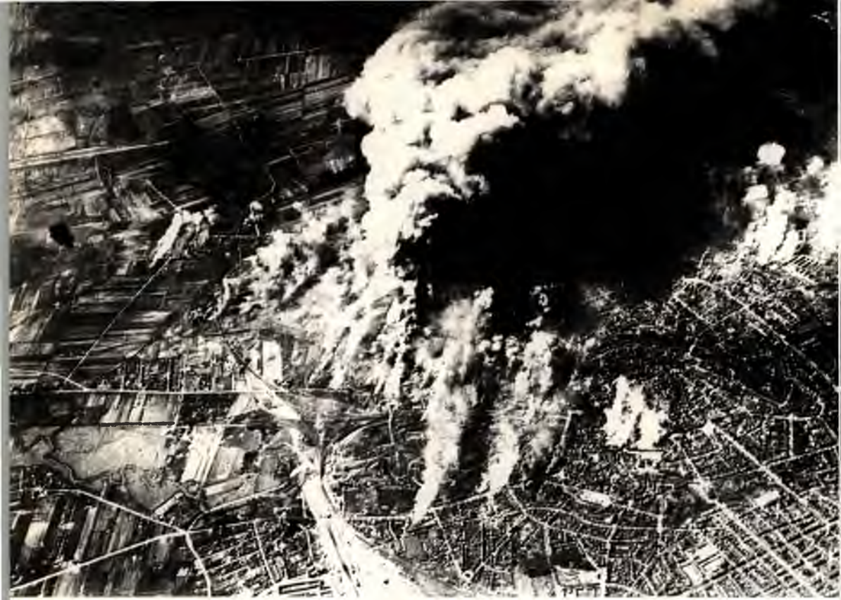
Die „Ausbombung“ einer Stadt. Britische Luflaufnahme Braunschweigs nach dem Angriff am 8. 4. 1944 – insgesamt erfolgten 21 Angriffe auf diese eine Stadt.
