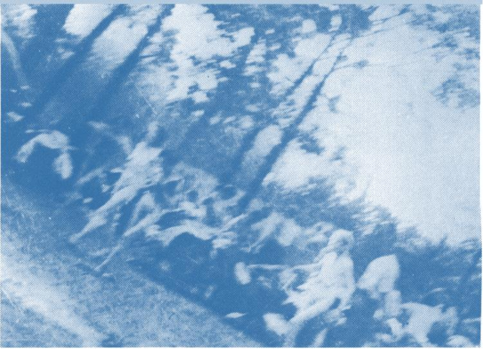
Frauen, die in die Kammern (Gasbunker) getrieben werden. Die Aufnahme wurde illegal durch ein Mitglied der Lagerwiderstandsbewegung gemacht und auf konspirativem Wege aus dem Lager gebracht.
