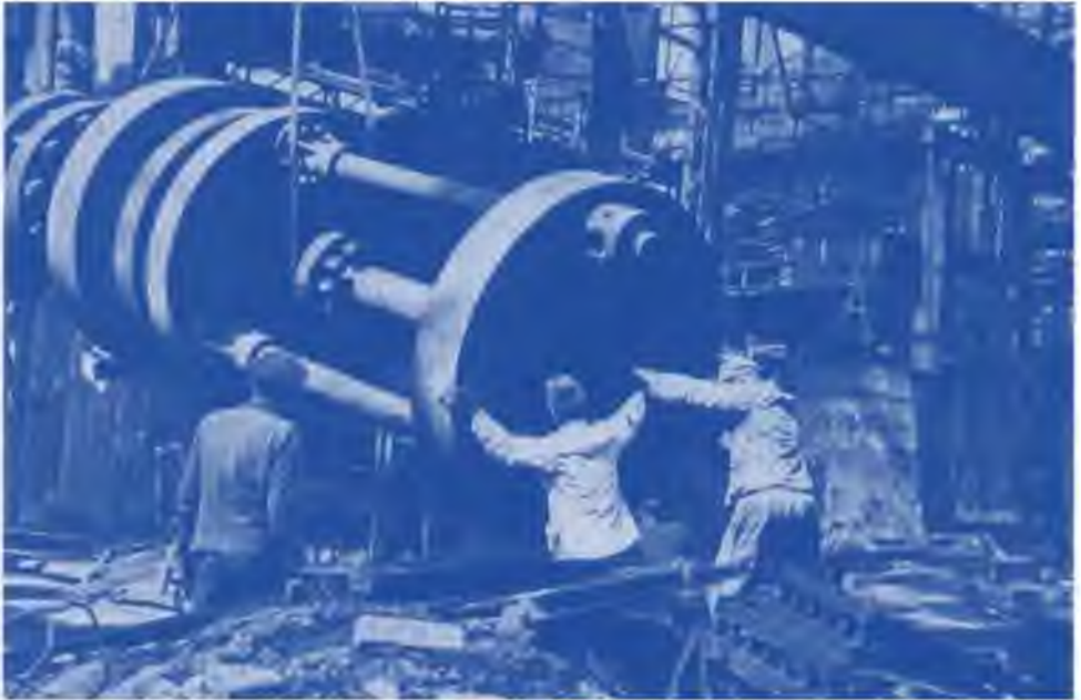
«Mit Krupp für alle Zeit Schluss machen»: Ziel der Alliierten war zunächst die vollständige Zerschlagung des Konzerns. Demontagen im Jahr 1949
