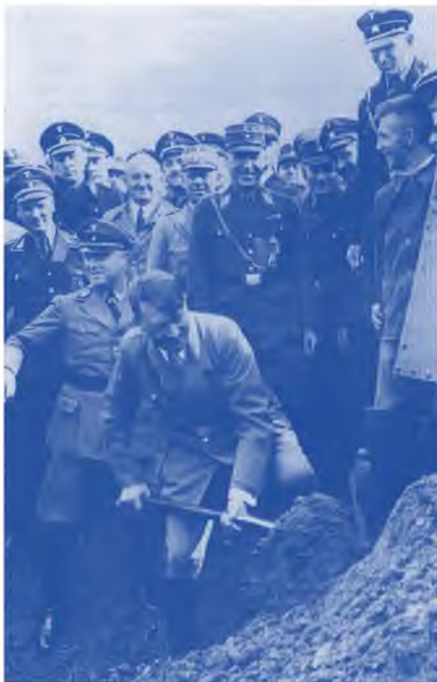
«Grandioser Propagandacoup»: Der erste Spatenstich Hitlers zum Bau der «Reichsautobahn» zwischen Frankfurt/M. und Heidelberg, September 1933
