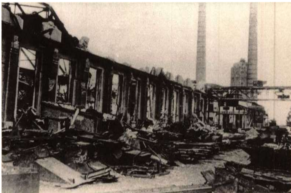
Eine der Aussenmauern der durch Bombentreffer am 20. August 1944 zerstörten Schmiedehalle.
