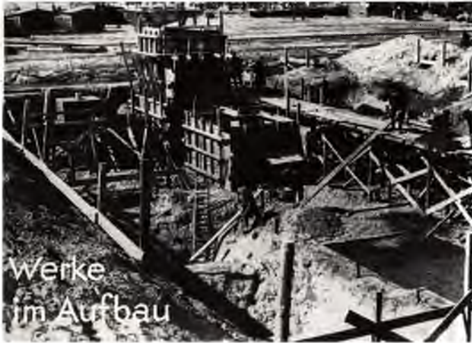
Baustelle der Hydrierwerke Pölitz AG. 1939.
