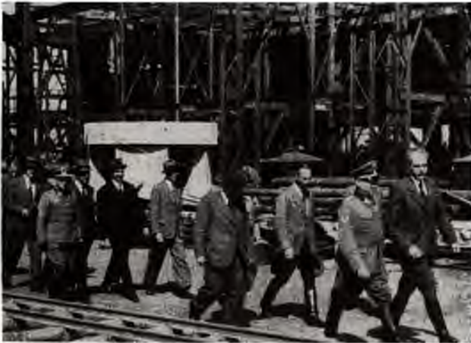
Werkleiter Dürrfeld führt den Staatssekretär Görings, Körner, der für den Vierjahresplan verantwortlich ist, über die Baustelle des I.G.-Werkes Auschwitz. 1942.
