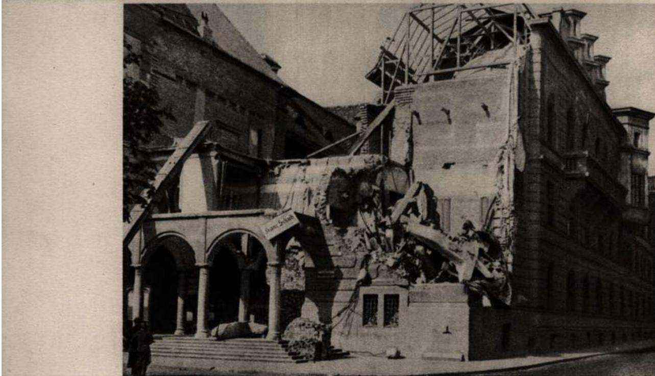
Auch der weitläufige Bau des Rathauses hat an mehreren Stellen Kriegsverletzungen erlitten. Das Dach des Mittelfaktes wurde vom Luftdruck zur Gänze abgetragen /
