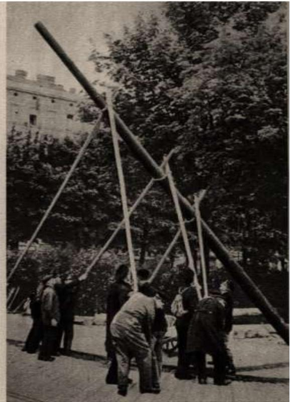
Oben links: Stadtbahnstation Josefstädter Strasse / Oben rechts: 500 Bombentrichter unterbrachen die Geleise / Unten links: Zerstörte Kraftstellwagen im Bahnhof Gürtel / Unten rechts: Der Vorrat an eisernen Masten war zu klein, um die zerstörten zu ersetzen. Es mussten zusätzlich Holzmasten aufgestellt werden.
