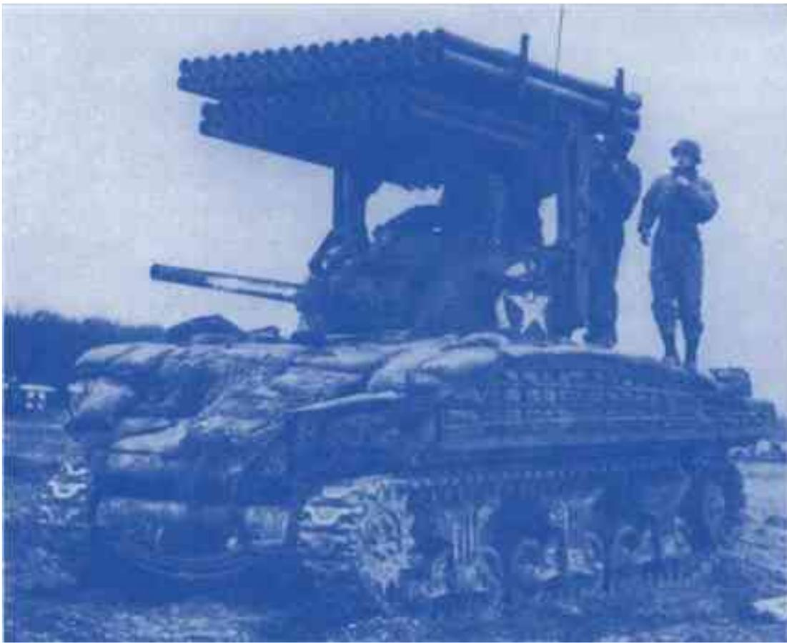
**60-läufiger Raketen-Werfer auf amerikanischem Sherman-Tank montiert**
